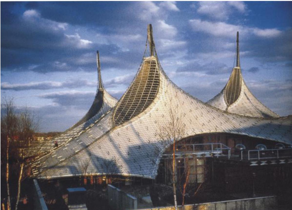
↖ Fig.133 Construção em rede metálica.
