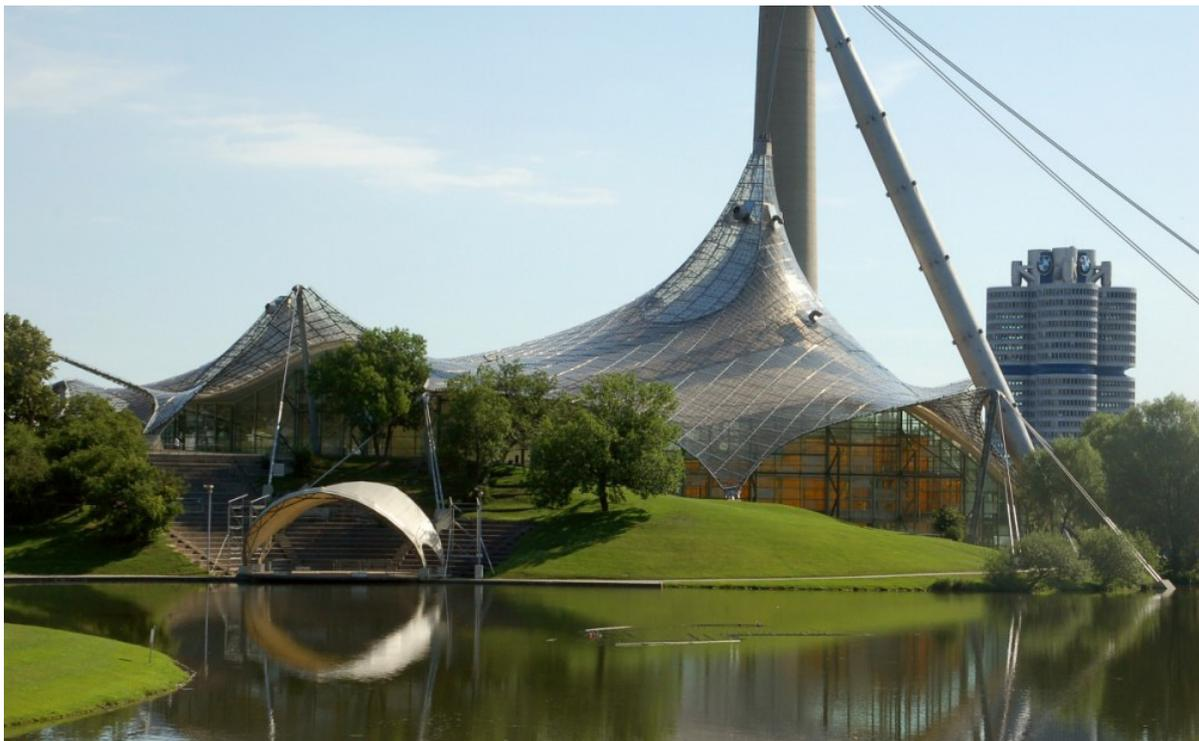
↑ Fig.180 Redes de cobertura e revestimento em acrílico transparente.
