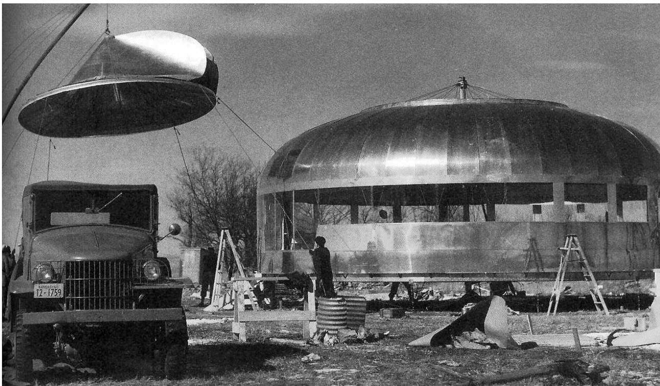
fig. 14 | Instalação do sistema de ventilação na Wichita House em 1946.
