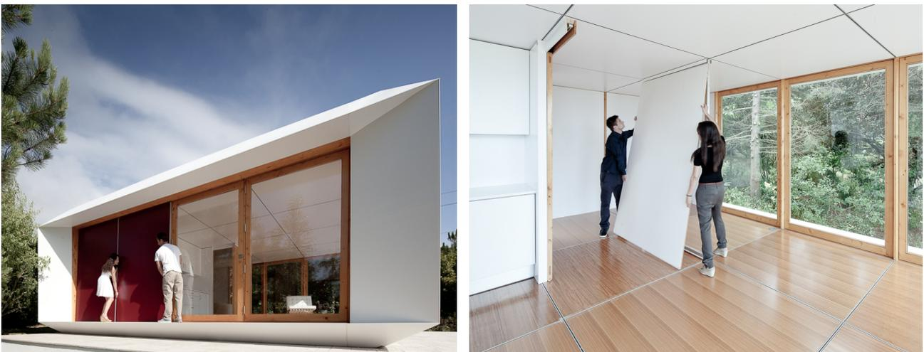
fig. 10 | Imagens exteriores da habitação pré-fabricada *Mima House*. Nestas imagens é visível a ocultação dos vãos exteriores com recurso aos mesmos módulos que são utilizados para a divisão do interior. Mima Architects, 2011.
