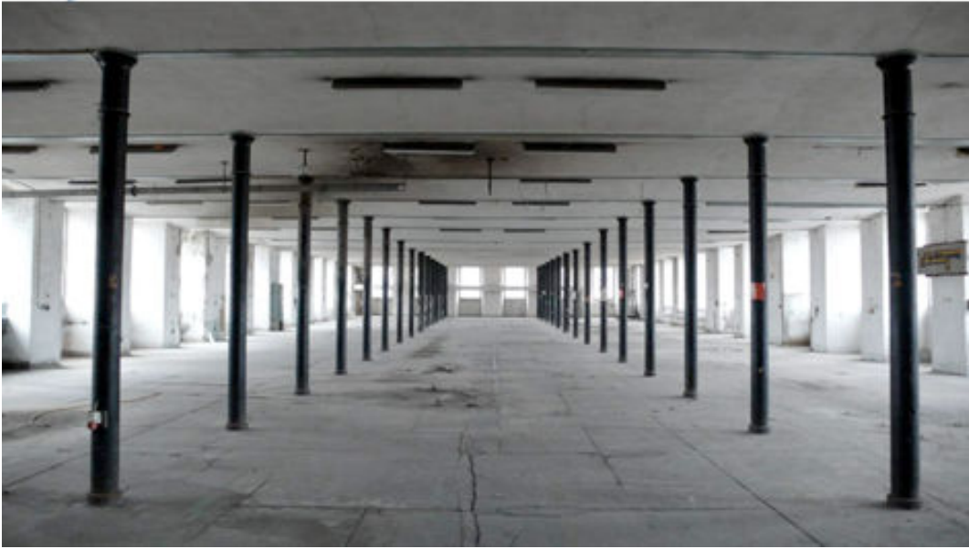
Imagem 73 – Sala das colunas no piso térreo da LX Factory.
