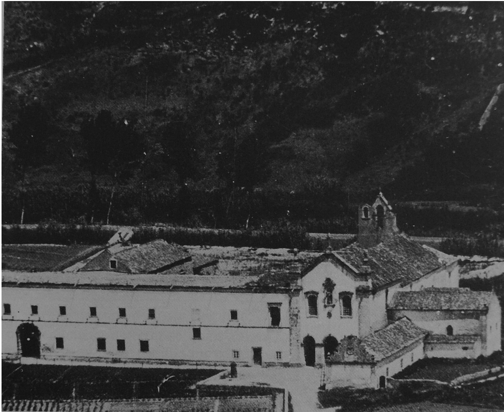
Imagem 3 – Fachada principal do convento e igreja de S. Francisco.
