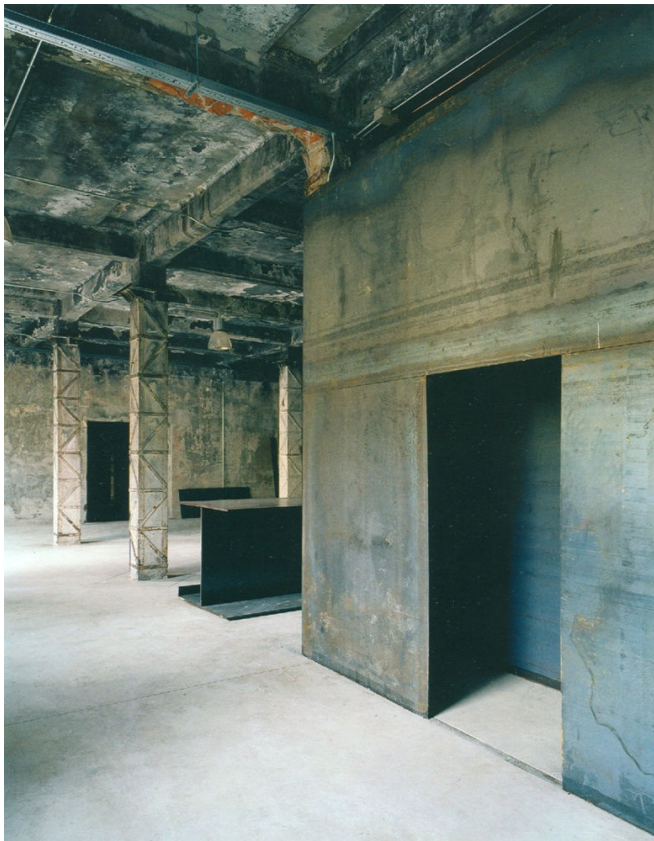
Imagem 68 – Interior do Matadero onde se pode ver uma viga metálica usada como balcão.
