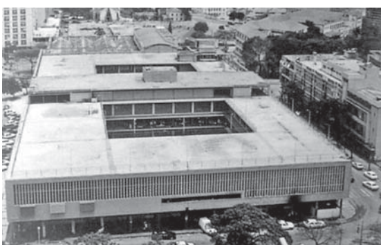
135. VISTA DA COBERTURA E ALÇADO NASCENTE
