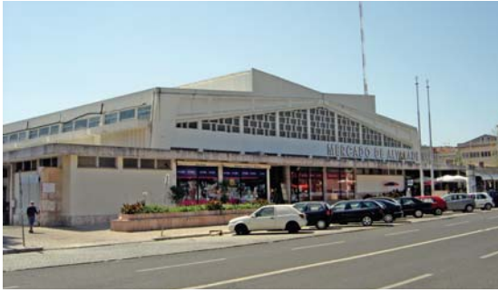
172. FACHADA DO MERCADO DE ALVALADE NORTE (AV. RIO DE JANEIRO)
