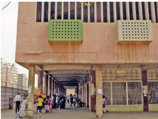
139. GALERIA EXTERIOR NO PISO TÉRREO
