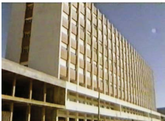
18. HOSPITAL DE SÁ DA BANDEIRA/LUBANGO, JOSÉ PINTO DA CUNHA (1968-1970)
