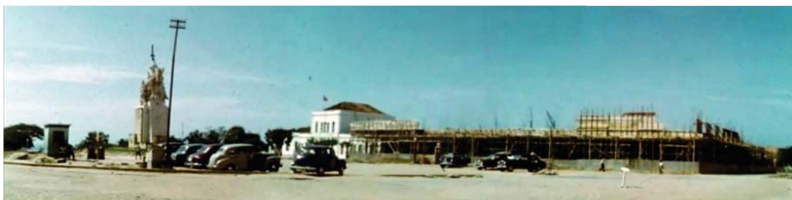
113. LARGO DOS LUSÍADAS NO ANO 1955 COM O MERCADO EM CONSTRUÇÃO
