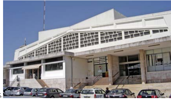
173. FACHADA DO MERCADO DE ALVALADE NORTE (RUA JOSÉ DURO)
