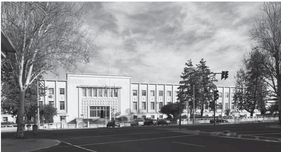
2 | Fachada principal do Laboratório Nacional de Engenharia Civil..
