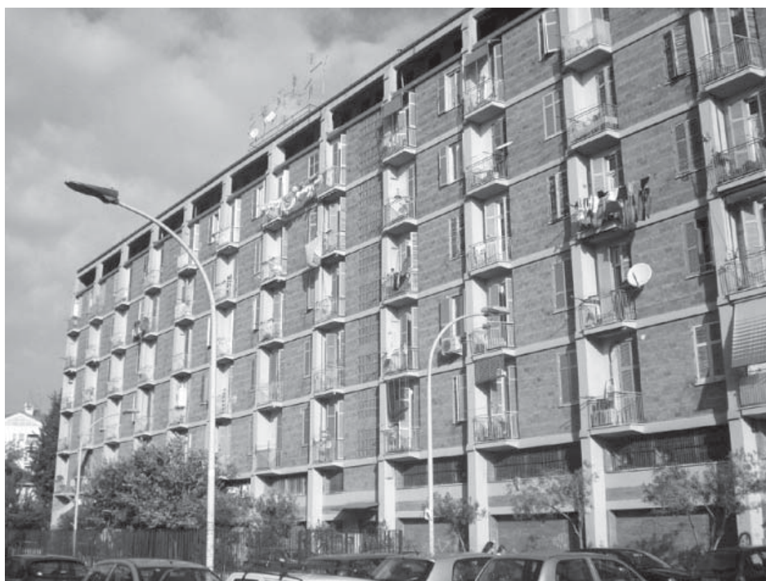
24 | Conjunto habitacional Tuscolano II, de Mario De Renzi e Saverio Muratori, 1950-1960.
