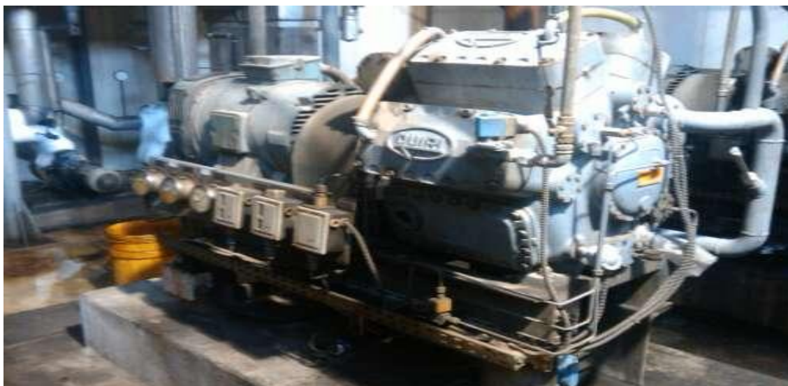
Figura 6 - Compressor de amoníaco de marca QUIRI.
