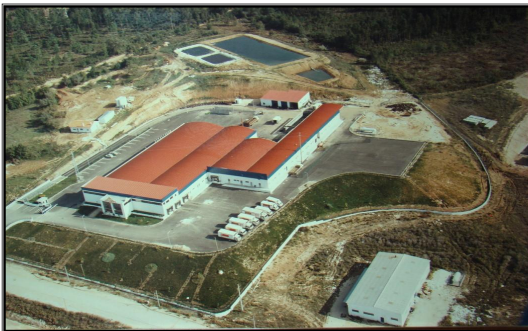
Figura 1 - Vista aérea da unidade industrial.
