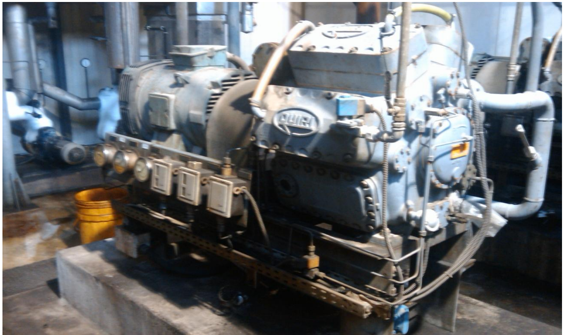
Figura 11 - Compressor alternativo marca QUIRI com 8 cilindros.
