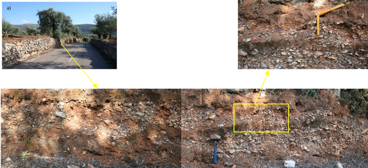
Figura 3. Aspecto do afloramento 1: a) enquadramento; b) Articulação das diferentes litofácies; c) pormenor do afloramento.
