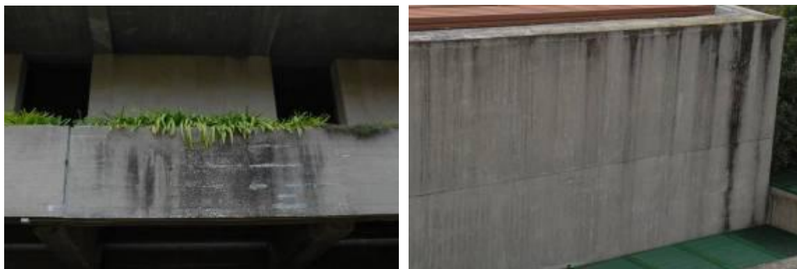
Figura 150. Manchas nas superfícies de betão: (a) sujidade e depósito de sais na platibanda do museu; (b) sujidade na fachada do auditório.
