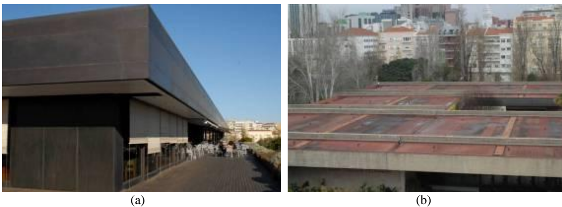
Figura 139. Cobertura: (a) edifício sede; (b) museu.
