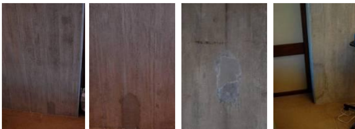
Figura 159. Reparções em pilares no interior da sede.
