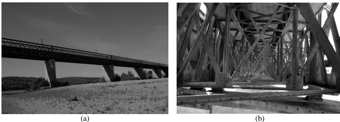
Figura 28. Ponte da Praia do Ribatejo sobre o rio Tejo: (a) vista geral dos tramos monitorizados; (b) parte inferior do tabuleiro.
