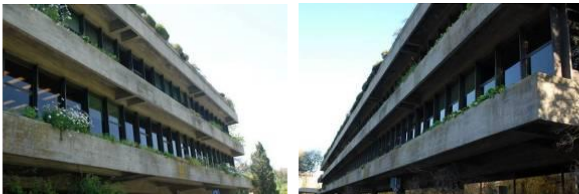
Figura 141. Edifício sede: fachada principal (Norte).
