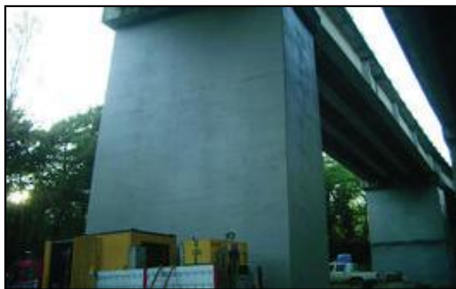
Figura 38 - Reparação estrutural com betão autocompactável de elevada estabilidade dimensional
