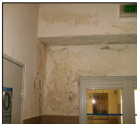
Figura 2.3 – Presença de bolor e manchas de humidade nas instalações sanitárias (esq.) e nos corredores do piso 1 (dir.) (27-03-2008)
