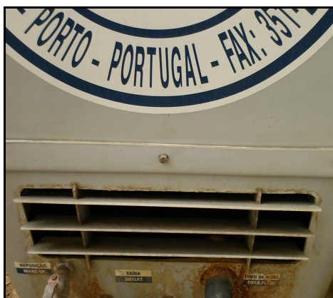
Figura 2.4 – Torres de arrefecimento: Modelo TLA – 13 da Uniclíma em más condições de limpeza (esq.) e modelo ZEM 1000s da Zephyer (dir.) (01-07-2008)
