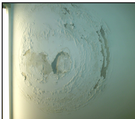
Figuras B.3 – Presença de humidade e bolor na entrada para a sala de trabalho da biblioteca (esq) e num dos corredores do 4º piso (dirt) (27-03-2008)
