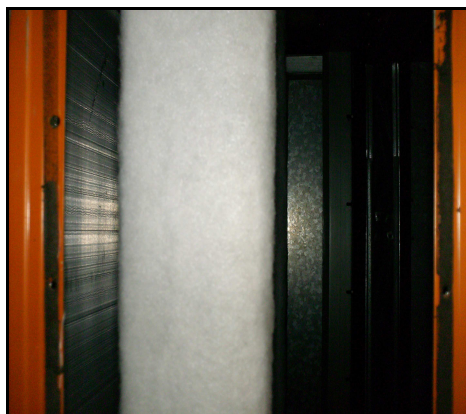
Figuras B.1 – Conduto de retorno (esq) e secção de filtragem do Anfiteatro I (dirt) (15-05-2008)
