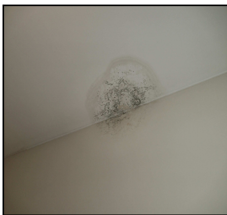
Figura 2.2 – Presença de bolor na sala 6.1 (esq.) e mancha de humidade na sala de informática I (dir.) (27-03-2008)
