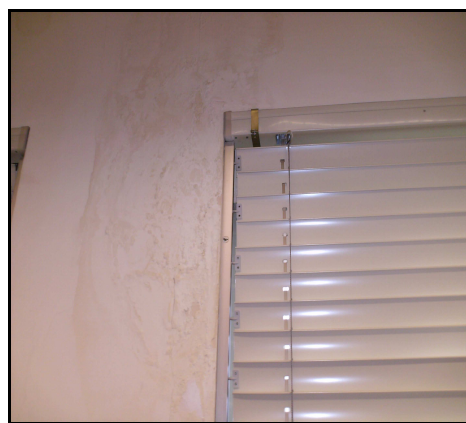
Figura 2.2 – Presença de bolor na sala 6.1 (esq.) e mancha de humidade na sala de informática I (dir.) (27-03-2008)
