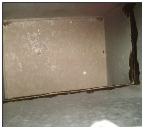
Figura 2.5– Presença de ninhos de pássaro na sala da UTA do Anfiteatro I (esq.) e sujidade da conduta de retorno da UTA (dir.) (27-05-2008)
