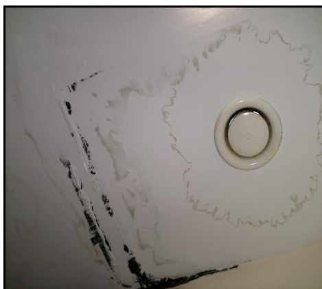
Figura 2.3 – Presença de bolor e manchas de humidade nas instalações sanitárias (esq.) e nos corredores do piso 1 (dir.) (27-03-2008)
