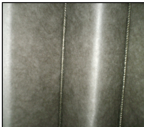
Figuras B.2 – Filtros da UTA do apoio informático (esq) e da UTA da Biblioteca (dirt) (15-05-2008)
