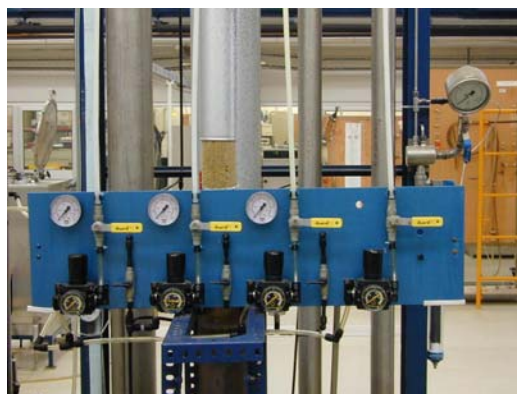
Figura 3.12. Painel de controlo da pressurização dos tanques.
