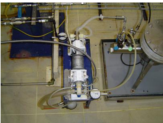
Figura 3.13. Bomba FMI de alimentação do ácido sulfúrico e da água.
