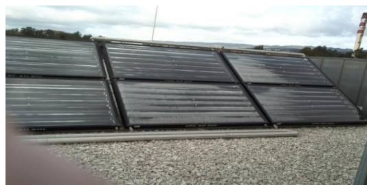
Figura 14 – Painéis CPC ao sol
