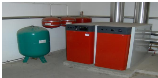
Figura 15 – Caldeiras a gás e vasos de expansão
