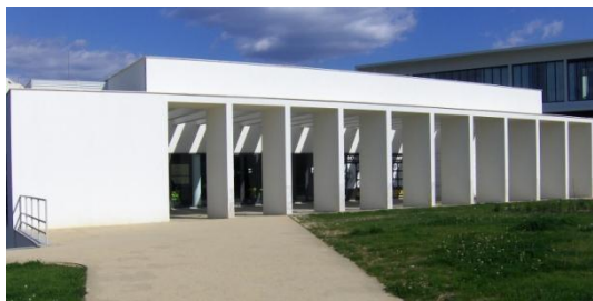
Figura 4 – Entrada do edifício virada a sudoeste
