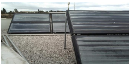
Figura 13 – Pormenor de montagem dos painéis
