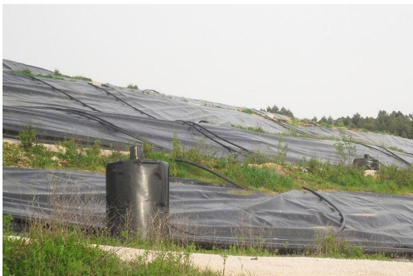
Figura 2.4: Poço de extracção de biogás selado.
