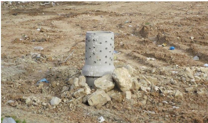
Figura 2.3: Cabeça de betão de um poço de extracção de biogás.
