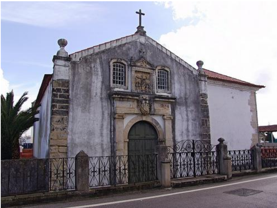
Imagem 42: Igreja da Misericórdia de Montemor-o-Velho. Foto AJS
