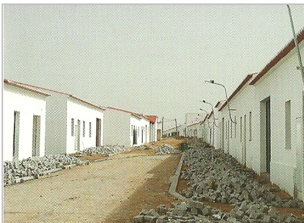
Figura 41- Nova aldeia da Luz, em fase de construção. Fonte: SARAIVA, 2005.
