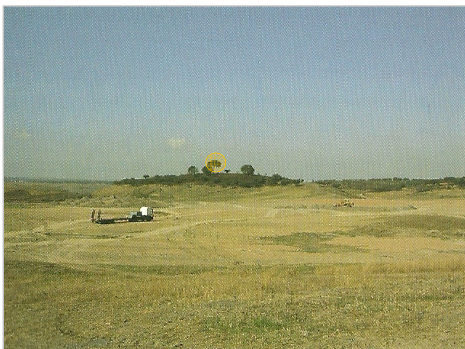
Figura 47- Velha Luz, Julho de 2003, após a conclusão da demolição. Fonte: SARAIVA, 2005.
