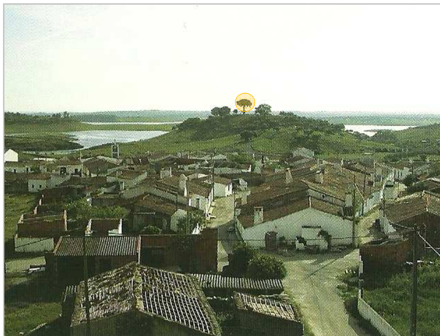
Figura 46- Velha Luz, Fevereiro de 2003, no início do desmantelamento. Fonte: SARAIVA, 2005.
