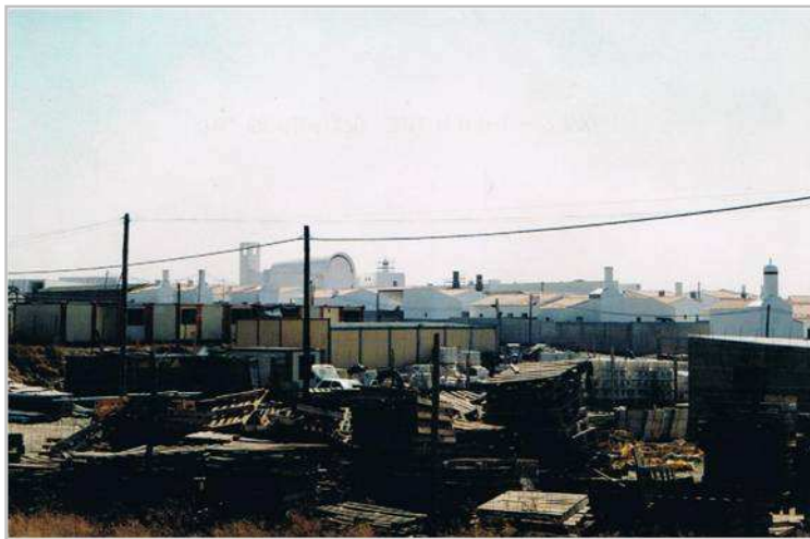
Figura 40- Estaleiros e construção da nova Luz.
