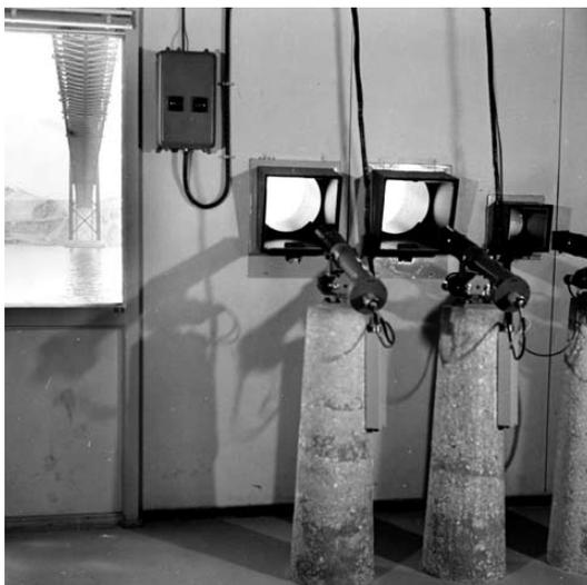
Figura 2.27 – Sistema de medição, sem contacto, desenvolvido pelo LNEC na década de sessenta.
