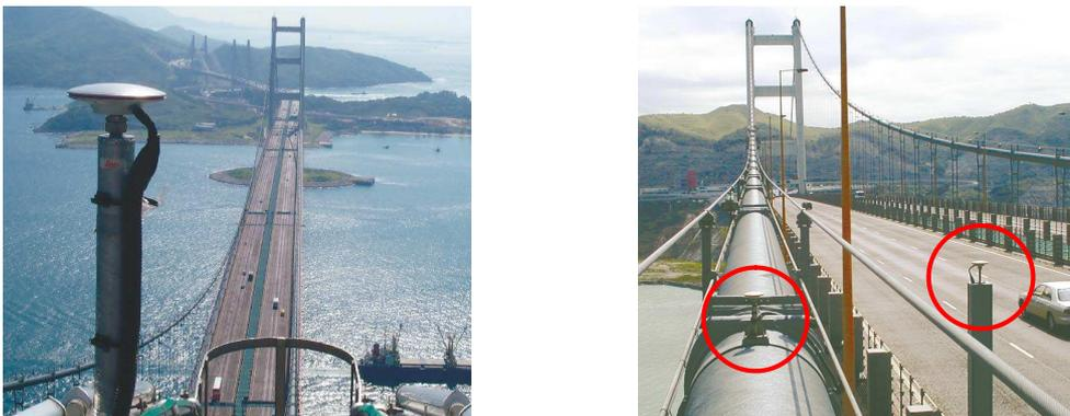
Figura 2.6 – Ponte *Tsing Ma*: antenas de GPS instaladas na torre (esq.), no cabo de suspensão e no tabuleiro (dir.) (adaptado de Wong, 2001).
