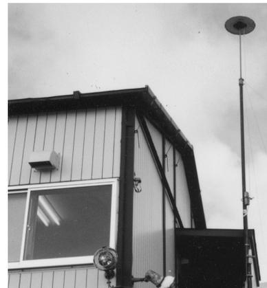
Figura 2.4 – Antena de GPS de referência, instalada na cobertura do edifício (Nakamura, 2000).
