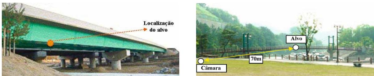
Figura 2.44 – Observação dos deslocamentos de um viaduto (esq.) e de uma ponte pedonal (dir.) (adaptado de Lee, 2006-a).
