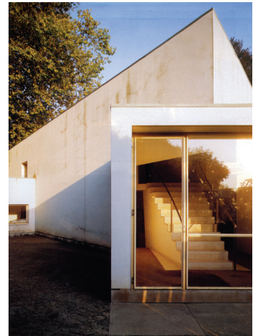
Álvaro Siza, Pavilhão Carlos Ramos, FAUP, Porto, 1985
