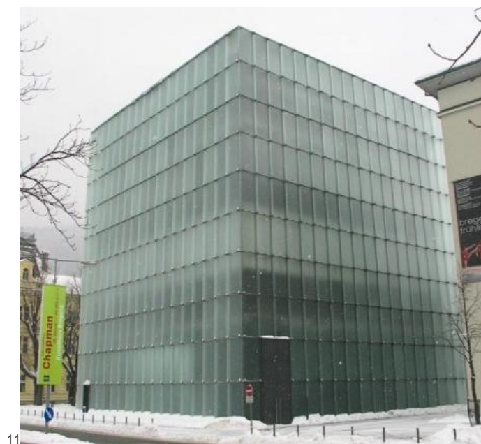
Peter Zumthor, edifício Museu Kunsthhaus (1993-97) em Bregenz na Áustria.
