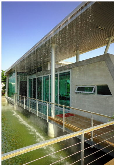
Figura 2.31 - Cortina de água pela fachada do Tea Pavilion, Tailândia ( http://www.archdaily.com )
