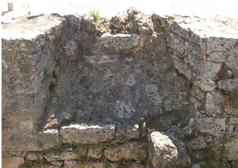
Figura 77 – Pormenor de uma janela em boca de lobo do criptopórtico das lojas a sul da via.
