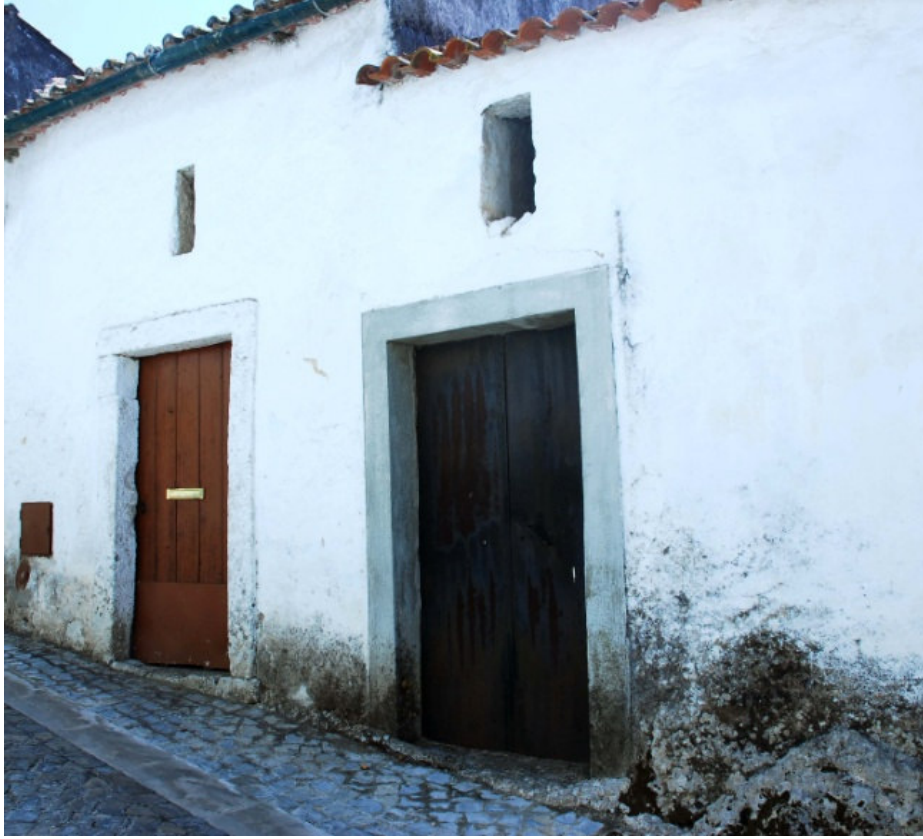
Figura 119 – Sobrevivência da arquitectura de espaços unimodulares com mezaninos. Arquitectura popular em Condeixa-a-Velha.
