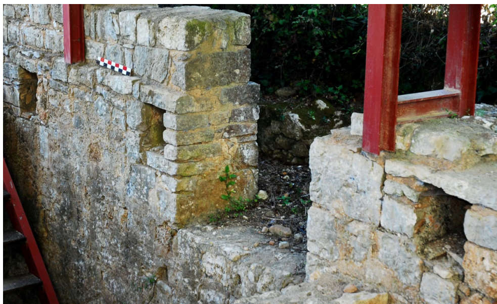
Figura 97 – Vestígios de dispositivos de soalhos de madeira na casa dos Repuxos: encastramento de traves no corredor nº 4. (A abertura da porta não é contemporânea).
