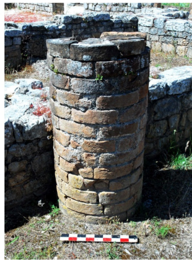
Figura 118 – Pilares de suporte de pavimentos de mezaninos (insula do vaso fálco e casa dos esqueletos).
