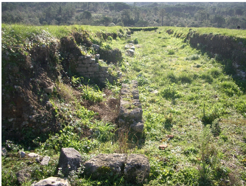
Figura 52 – Aspecto do edifício da pátera Emanuel.
