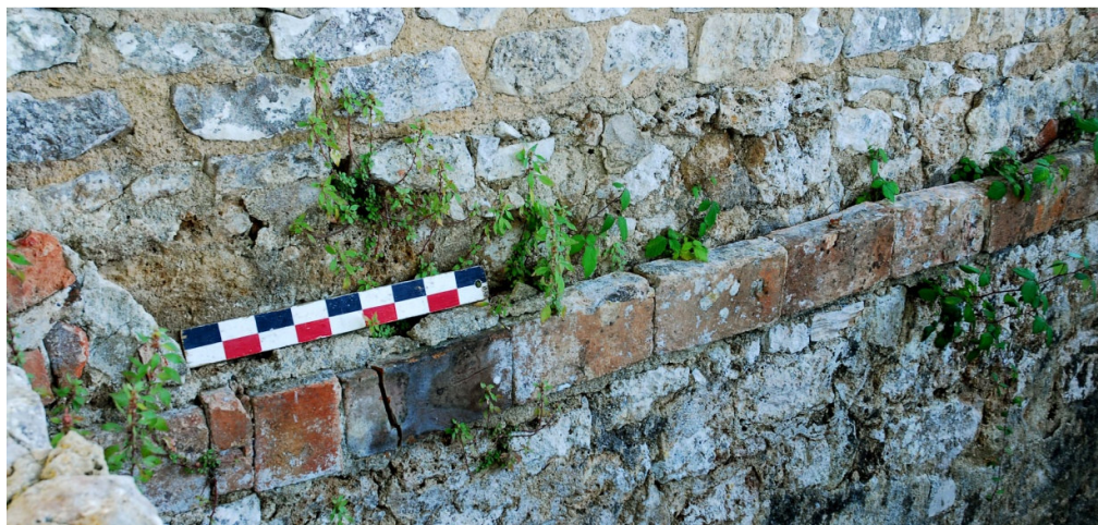
Figura 98 – Vestígios de dispositivos de soalhos de madeira na casa dos Repuxos: apoio de traves transversais na sala nº 10.
