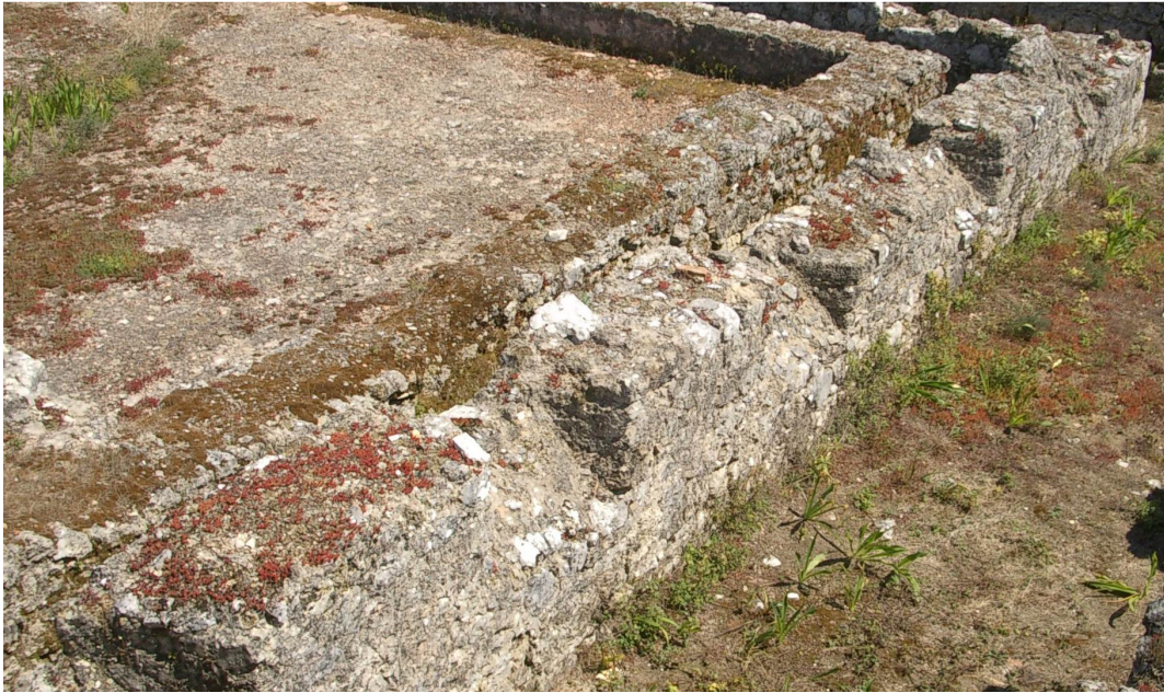
Figura 128 – Aspecto da ala Leste do criptopórtico da ínsula do aqueduto.
