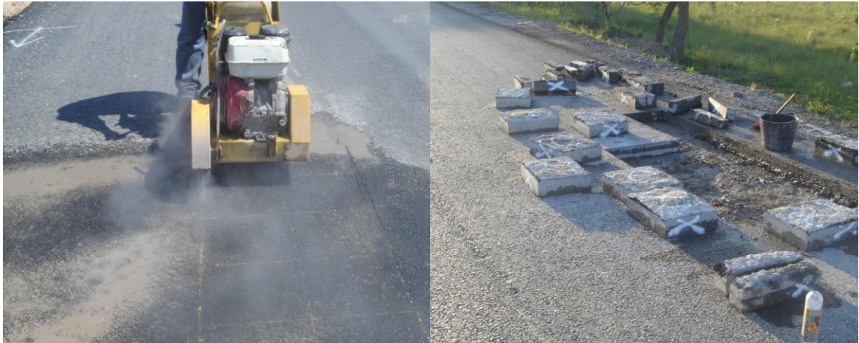
Figura 4.39 - Extracção de lajes no pavimento do trecho de Messines
