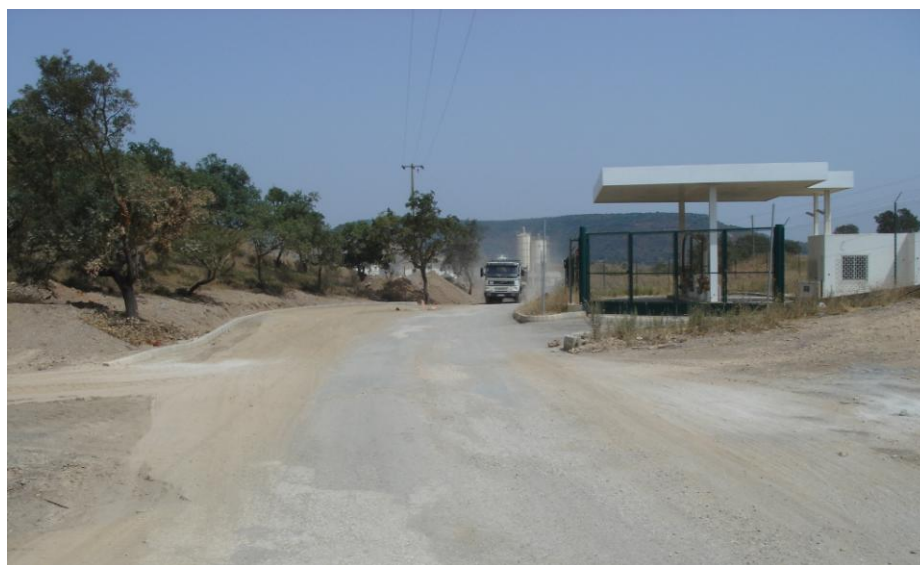
Figura 4.31 - Aspecto geral do pavimento existente antes da execução dos trechos experimentais de Messines
