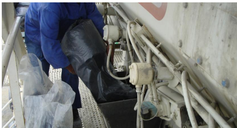
Figura 4.64 -Incorporação manual de borracha na central de betuminoso
