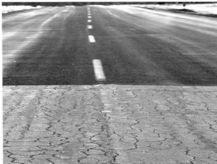
Figura 2.13 - Trecho Experimental de SAM e SAMI em Arizona (Zareh e Way, 2009)
