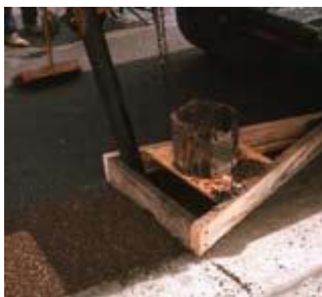
Aplicação de Lama Asfáltica com betume- borracha em 1970
