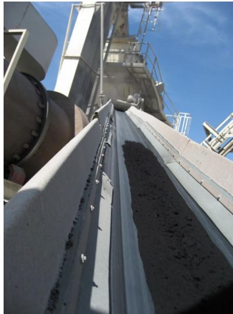
Figura 4.37 - Incorporação de borracha pelo anel de reciclagem de fresados na central de betuminosos de Ourique
