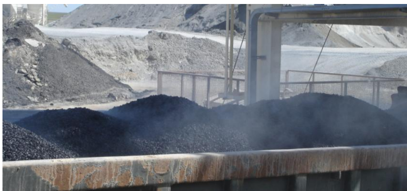
Figura 4.36 - Aspecto da mistura betuminosa com betume de borracha na central de betuminoso de Ourique
