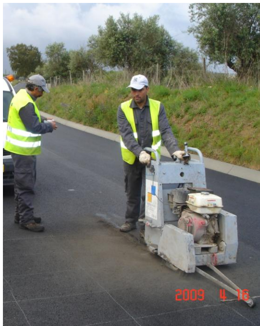
Figura 4.66 - Extracção de lajes no pavimento do trecho de Avis
