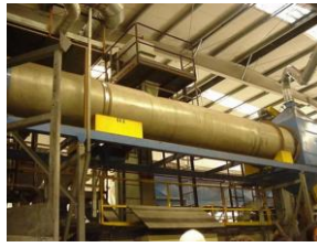
Fase 4: Secador. Remover a humidade das partículas de borracha que estiveram em contacto com o azoto sob forma dos pedaços de 10-15 cm
