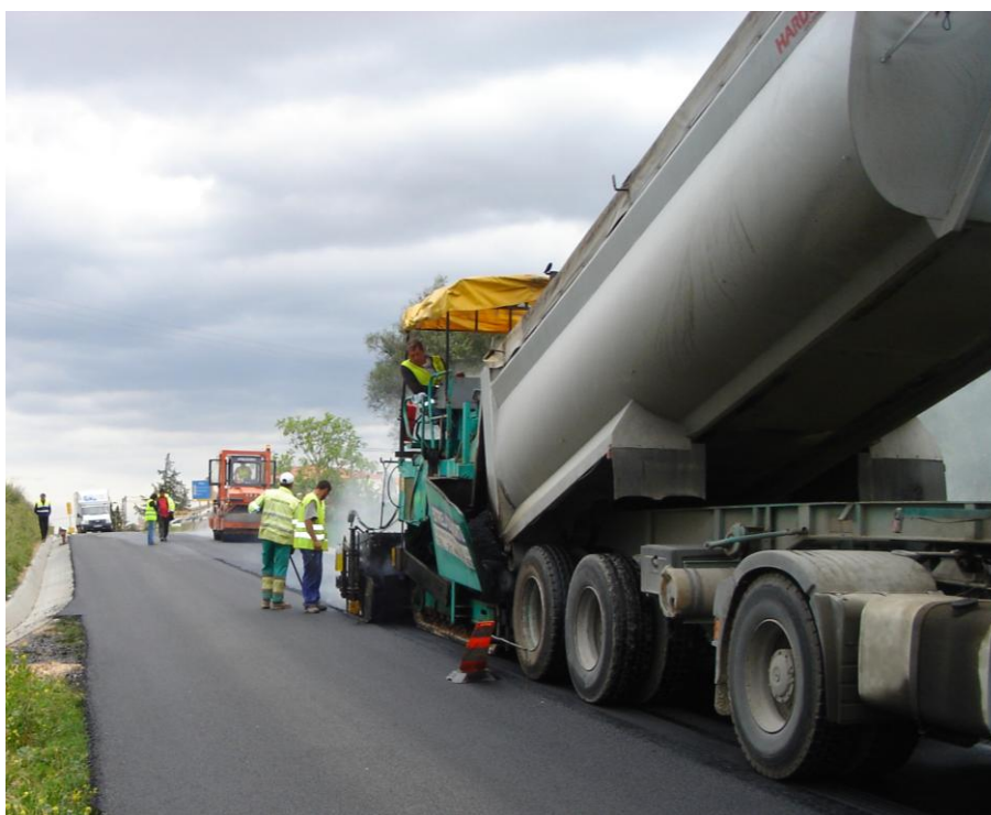
Figura 4.88 - Aspecto do processo construtivo da aplicação da MBR-VS e circulação do tráfego
