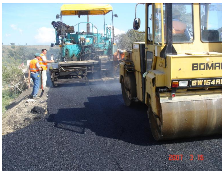
Figura 4.38 - Espalhamento e compactação da mistura TB1 no trecho de Messines
