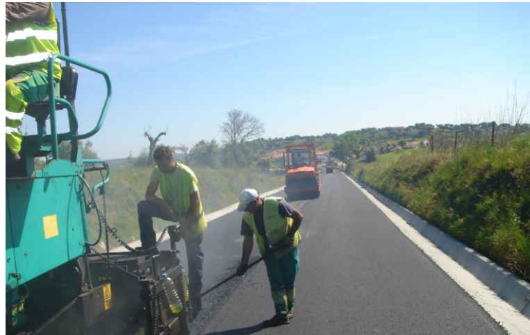
Figura 4.65 - Espalhamento e compactação da mistura betuminosa TA no trecho de Avis
