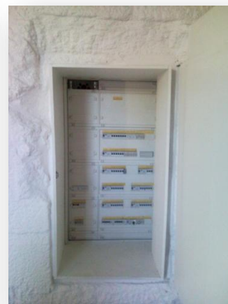
Fig. 86- Pormenor da parte interna do vão de uma antiga roda
