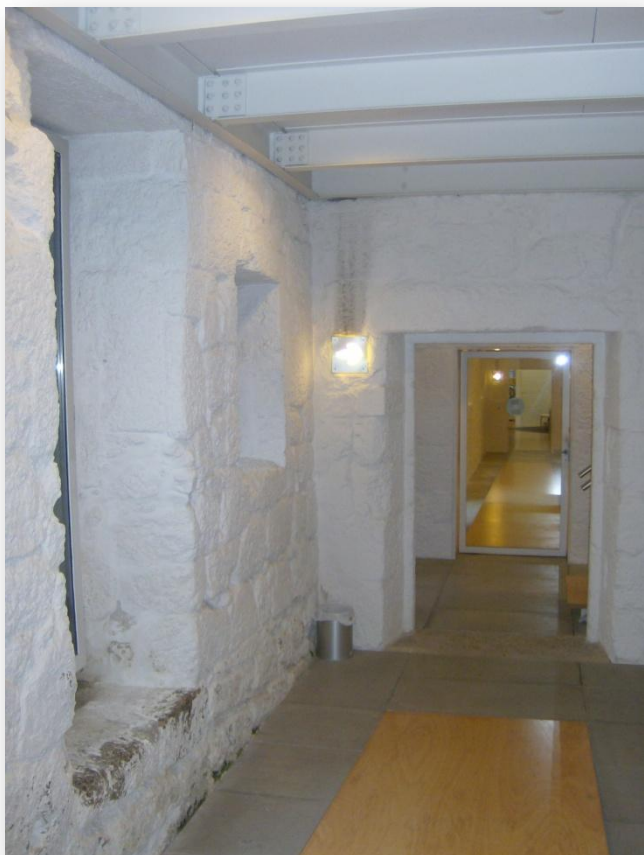
Fig. 84- Aspecto geral do compartimento, onde estava instalado o parlatório das religiosas, actualmente, serve de corredor de acesso aos reservados e onde se encontra instalado o quadro eléctrico da biblioteca
