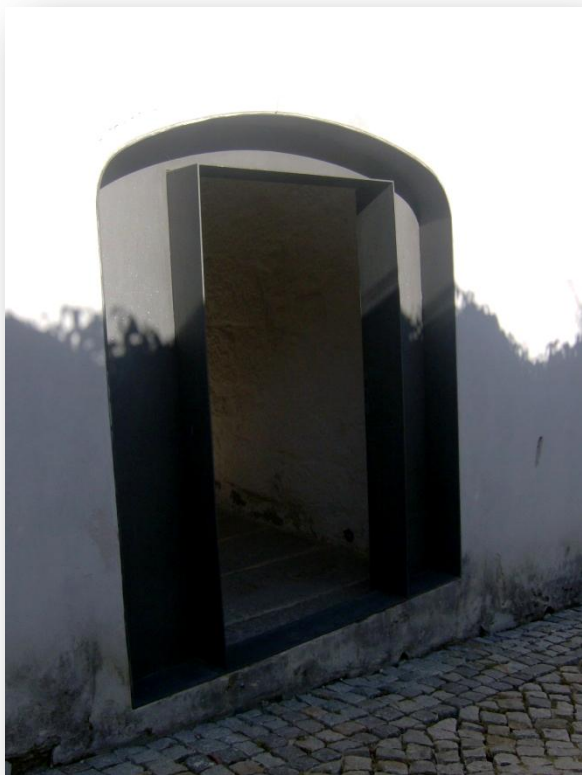
Fig. 81- Pormenor da actual porta, para a rua do Caminho Novo, da antiga portaria do mosteiro.
