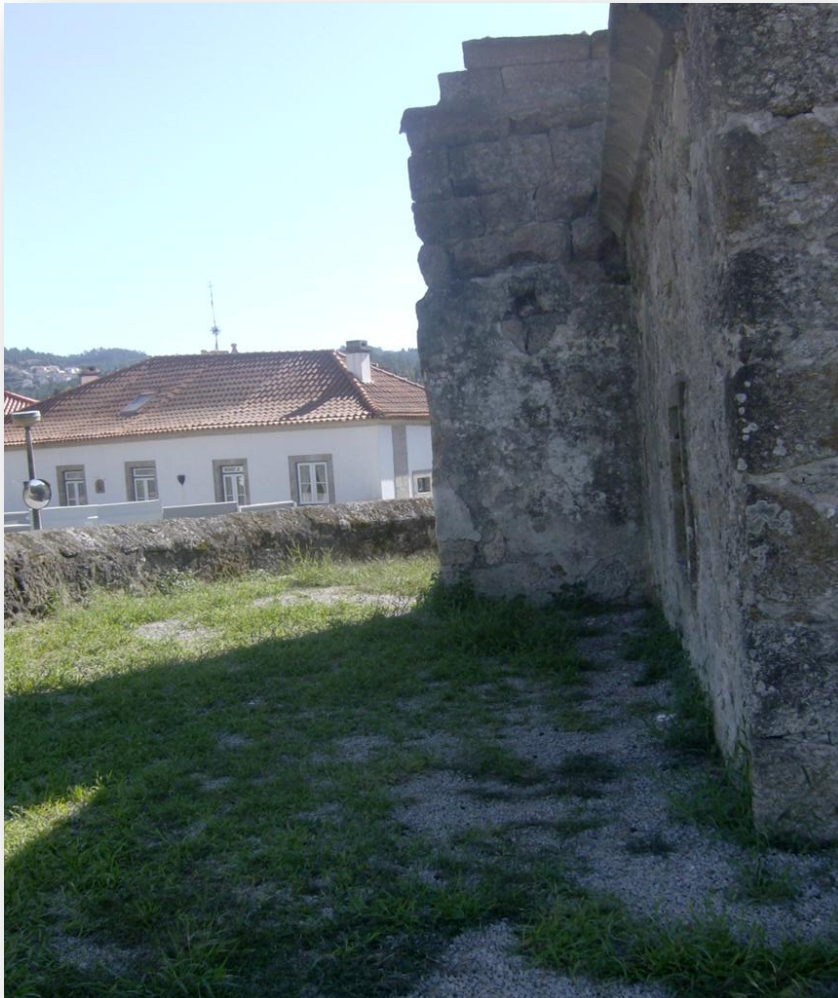
Fig. 73- Espaço ainda por escavar, onde se encontrarão os alicerces da sacristia da igreja de Santa Clara de Amarante. Foto: Daniel Ribeiro
