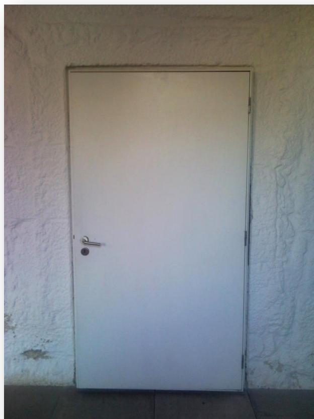
Fig. 88- Vão central onde se localizaria a grade do parlatório, actualmente um armário do quadro eléctrico da biblioteca
