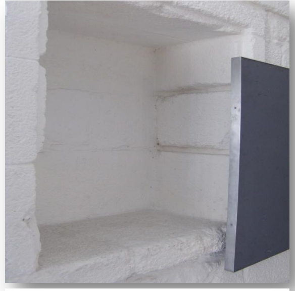
Fig. 64 - Pormenor de um dos armários embutidos na parede.
