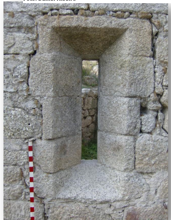
Fig.101- Janela rampeada dos dois lados correspondente a uma abertura original do edifício monástico Foto: Daniel Ribeiro
