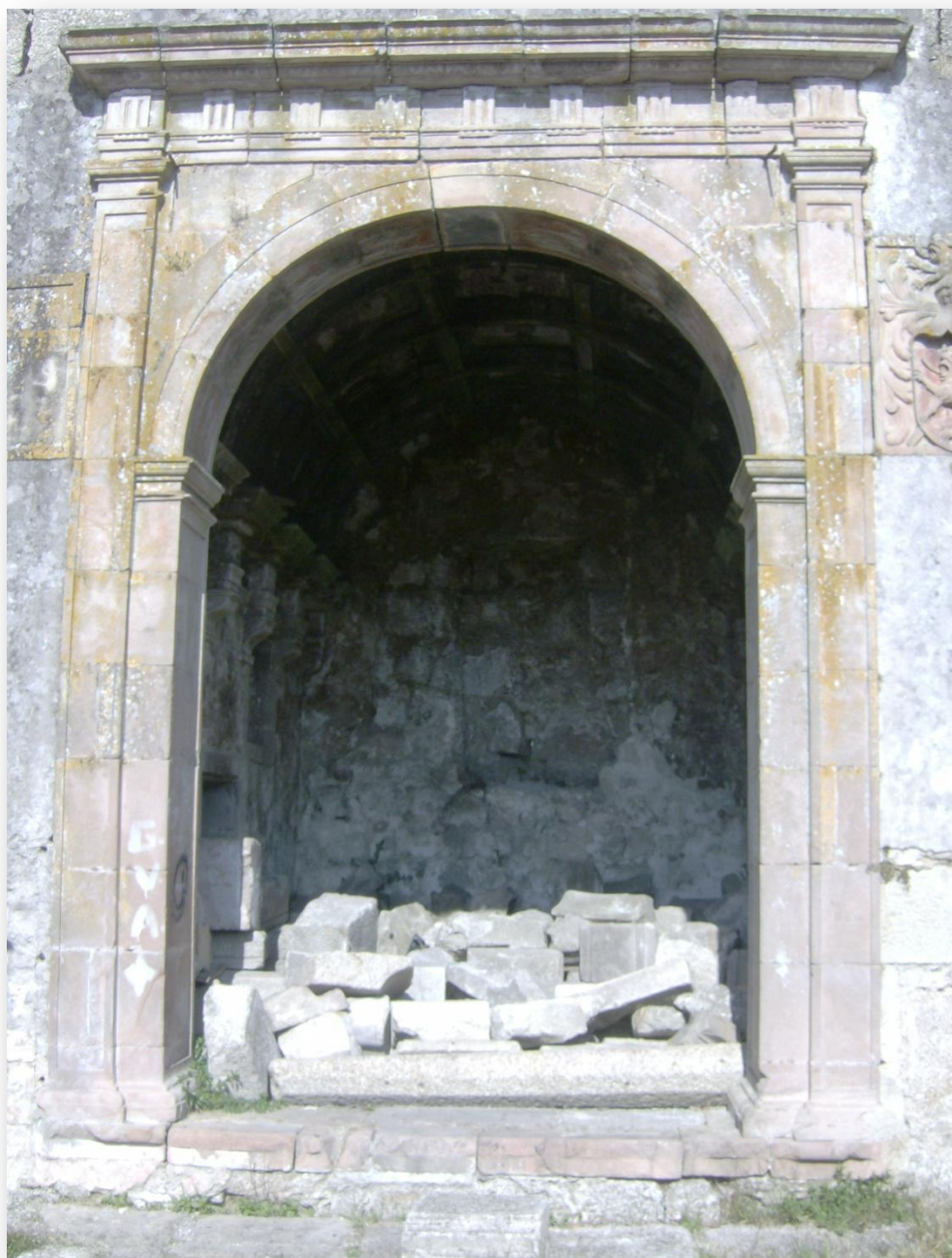
Fig. 43- Aspecto geral da Capela na actualidade
