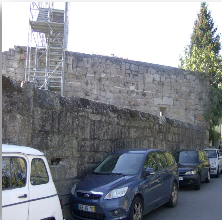
Fig.124- Pormenor da parte exterior de um troço da cerca do mosteiro, junto à actual Rua Capitão Augusto Casimiro Foto: Daniel Ribeiro
