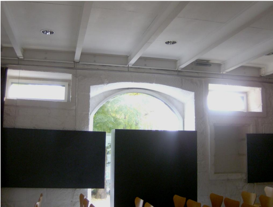
Fig. 64 – Vista geral do alçado poente do Baixo coro e da porta rasgada, durante a remodelação e adaptação do mosteiro em residência familiar.
