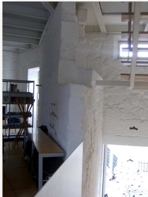
Fig.106 - Parte de um antigo alçado de interligação entre a Ala Sul e a Ala Oeste do antigo Mosteiro. Daniel Ribeiro
