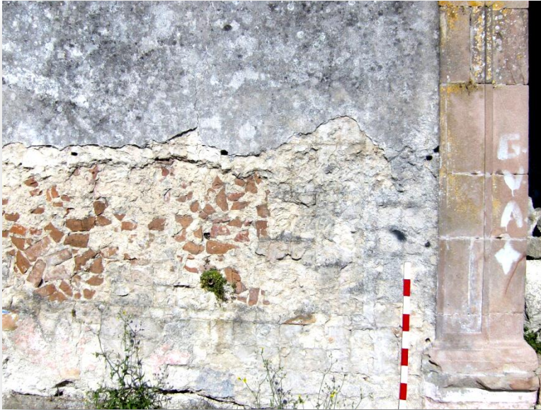
Fig. 41- Negativos do painel de azulejos e parte do aparelho de enchimento e preparação do alçado Este da igreja, para o mesmo.
