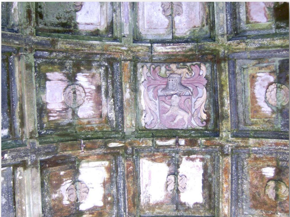
Fig. 19- Pormenor da abóbada de berço, com caixotões guarnecidos de rosetas esculpidas. No caixotão central pode ver-se brasão dos Cerqueiras, idêntico ao que se encontra na entrada para a capela.
