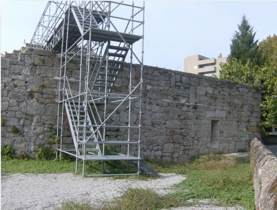
Fig.98- Vestígios do Alçado Sul do Mosteiro, postos a descoberto após a demolição das cavalariças e da "casa dos caseiros", da Casa da Cerca Foto: Daniel Ribeiro
