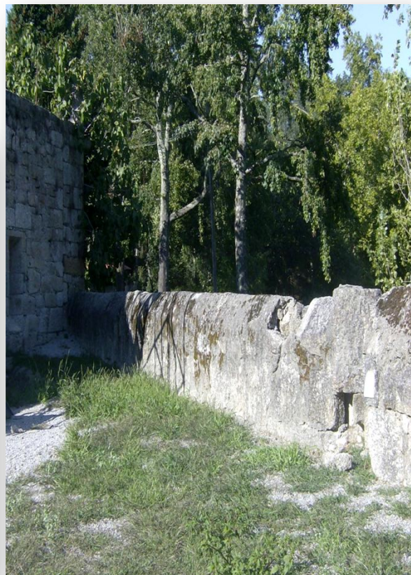
Fig.122- Troço da Cerca do Mosteiro junto ao alçado Sul do Claustro Daniel Ribeiro
