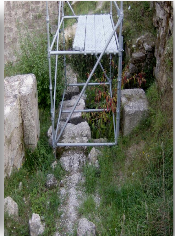
Fig.103 - Pormenor de uma passagem de um compartimento da ala Sul, para as arcadas do claustro Foto: Daniel Ribeiro
