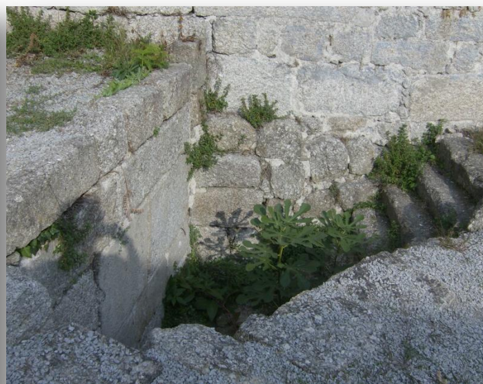
Fig. 94- Acessos a uma mina localizada junto ao fontanário.
