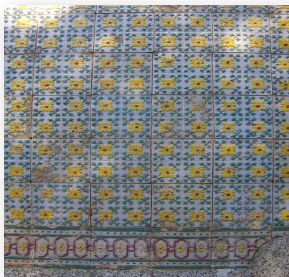
Fig. 129- Padrão dos azulejos relevados da fábrica de Massarelos, da fachada da actual biblioteca Foto: Daniel Ribeiro
