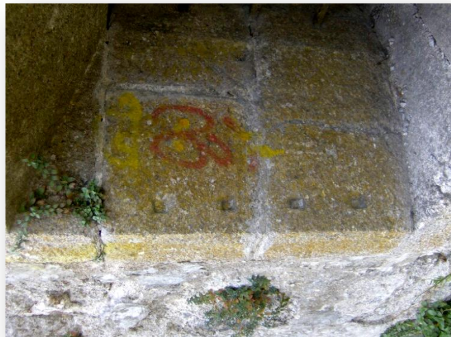
Fig. 71- Negativos de um gradeamento exterior da janela voltada a Sul da Capela de S. José, a qual se rasgaria para o interior da sacristia. Foto: Daniel Ribeiro
