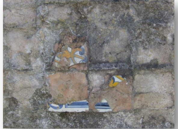
Fig. 42- Vestígios de azulejos policromados (azul, branco e amarelo) do painel do alçado Oeste da Igreja.
