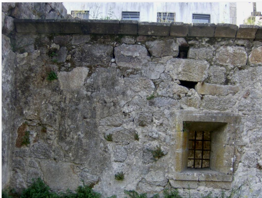
Fig. 72- Vestígios da Sacrista no alçado Sul da capela lateral de S. José, à qual esta estrutura parece ter adossado. Foto: Daniel Ribeiro
