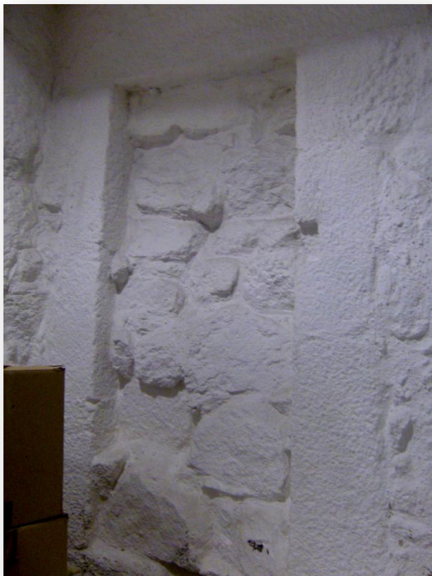
Fig. 85- O vão emparedado, da antiga grade do parlatório, visto a partir de um actual gabinete técnico da biblioteca, outrora a parte dos visitantes do mosteiro
