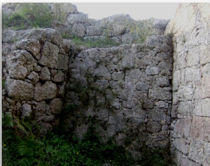
Fig. 110- Pormenor de uma divisão interna, da ala Este
