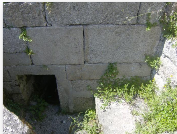
Fig. 96- Pormenor da entrada para a Câmara da Mina
