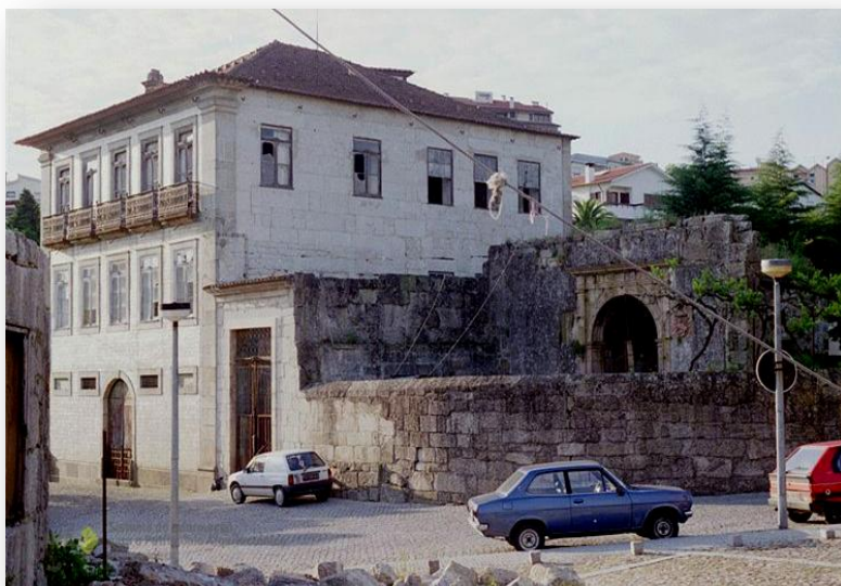
Fig. 44 - A fachada da casa da Cerca, em 1995.
