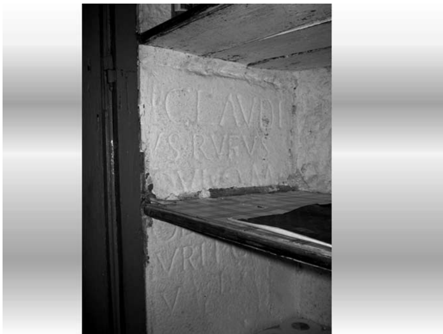
Fig. 7 – Inscrição na face interior do armário de parede
