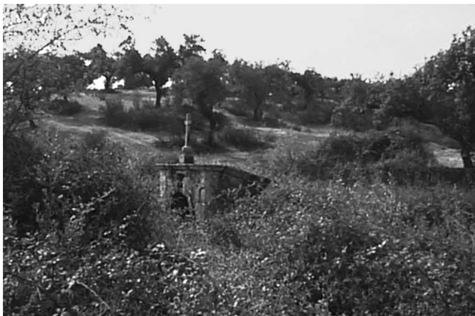
Fig. 8 – Fonte do Arco, nas proximidades de Idanha-a-Velha
