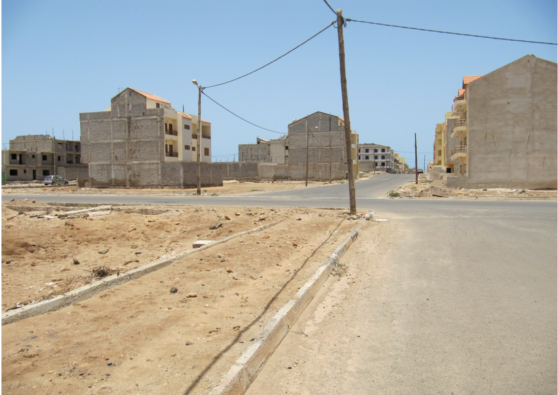
Área C: obras de infra-estruturação em que o arruamento foi desviado devido às construções ali existentes
