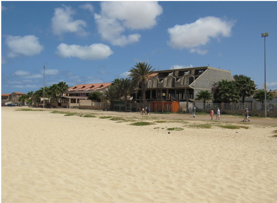
Edifício cuja construção se encontra embargada no eixo da rua de Ca' Tchicha
