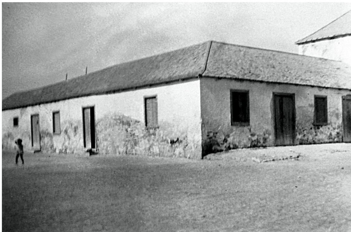
Foto parcial do edifício da Alfândega em 1945 SERVIÇOS Centrais da Administração Civil – Relatório sobre os Concelhos do Sal, Boavista, Santa Catarina, Fogo, Brava e Tarrafal. 1945
