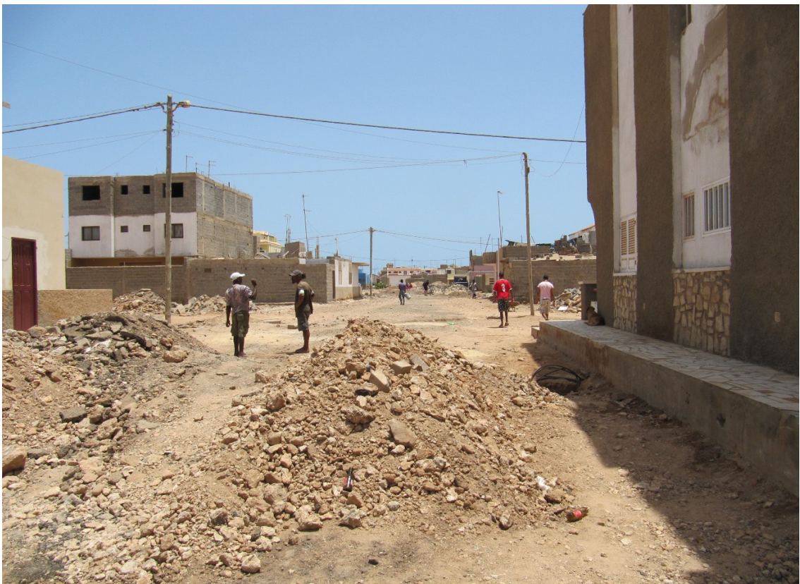
Área C: eixo de ligação entre o mercado municipal e a praça do fontanário em obras. Os edifícios laterais não foram projectados de forma a confrontar com uma rua pedonal
