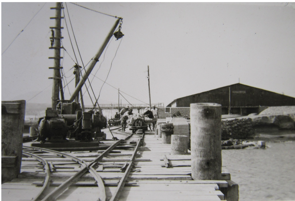
À esq. foto do pontão de Santa Maria com os carris e guindaste para deslocação das cargas de sal e armazém da Companhia de Fomento de Cabo Verde Fornecida por Joãozinho Rasta
