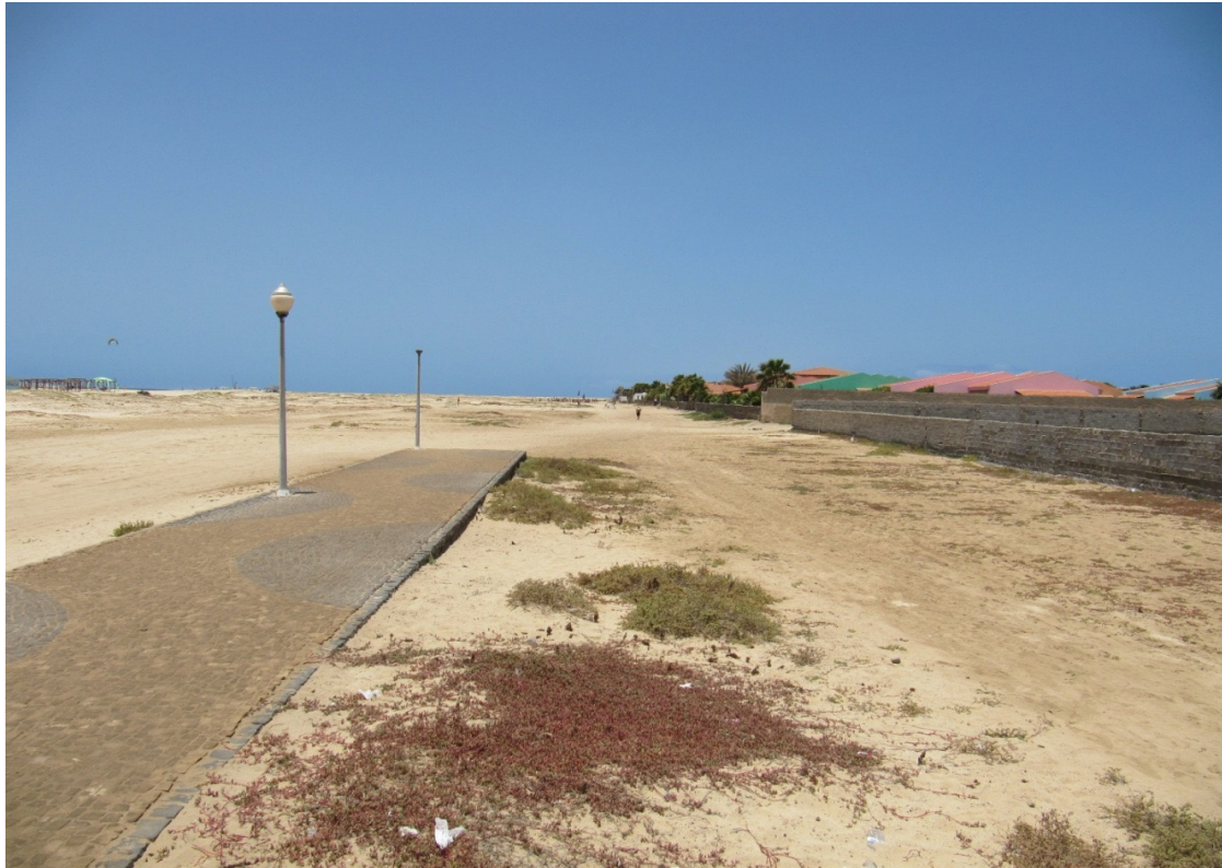
Calçada pedonal de acesso aos hotéis localizados a Oeste da cidade, sem remate
