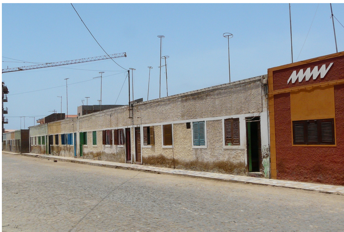
Rua das Salinas, no núcleo original de Santa Maria, cujos edifícios possuem valor de conjunto Foto de Luís Pinto
