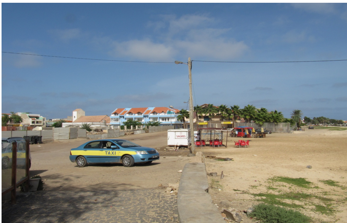
Espaço junto ao pontão de Santa Maria. Arruamento, acesso à praia e atrás um lote expectante no local da antiga CFCV para construção de um futuro hotel
