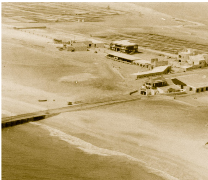
Edifício/armazém de sal em 1972
