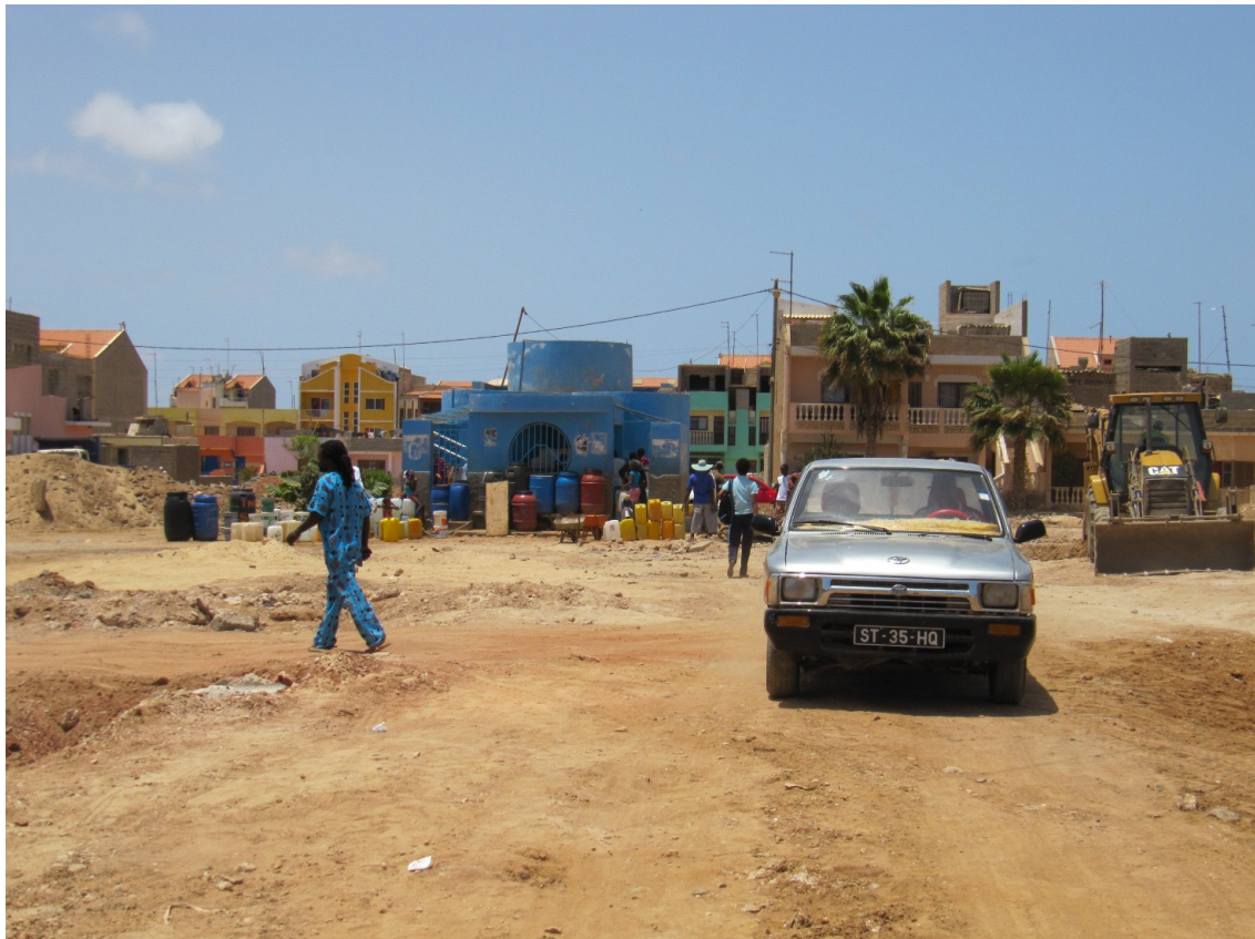
Espaço junto ao fontanário de Santa Maria, actualmente em obras
