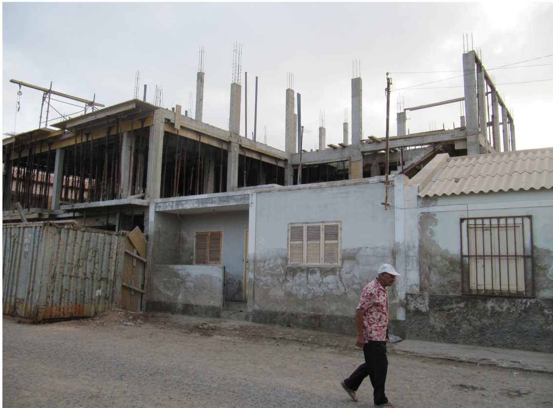
Obra em curso no núcleo original , na rua de Ca' Tchicha
