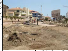
Acesso ao pontão
