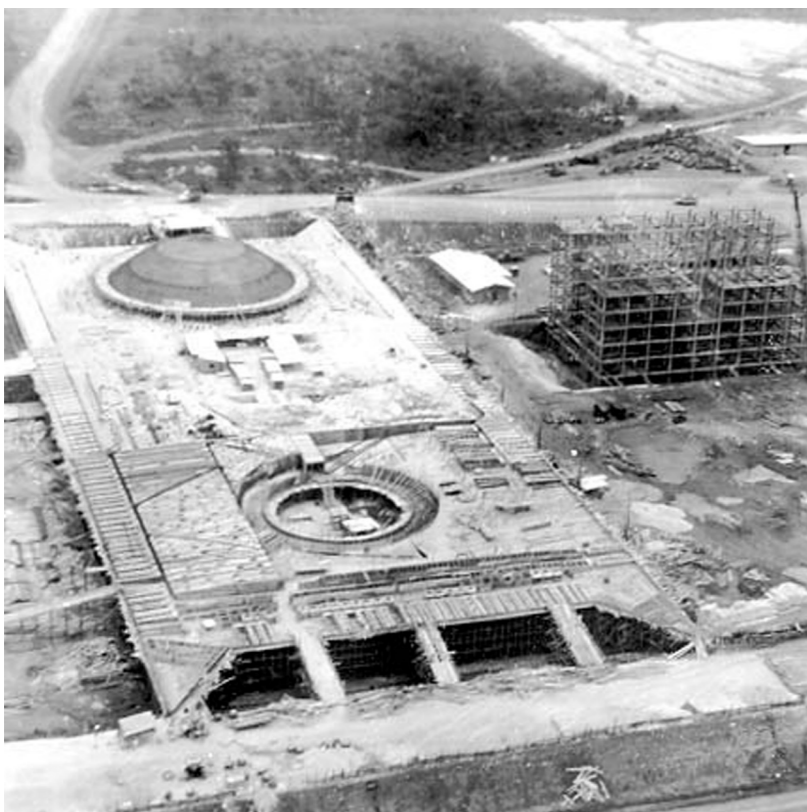
Eixo Monumental em construção | Vista aérea Foto do Arquivo Público de Brasília
