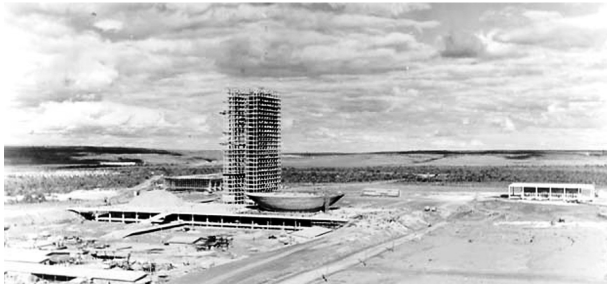
Eixo Monumental em construção | Vista aérea do Congresso Foto do Arquivo Público de Brasília
