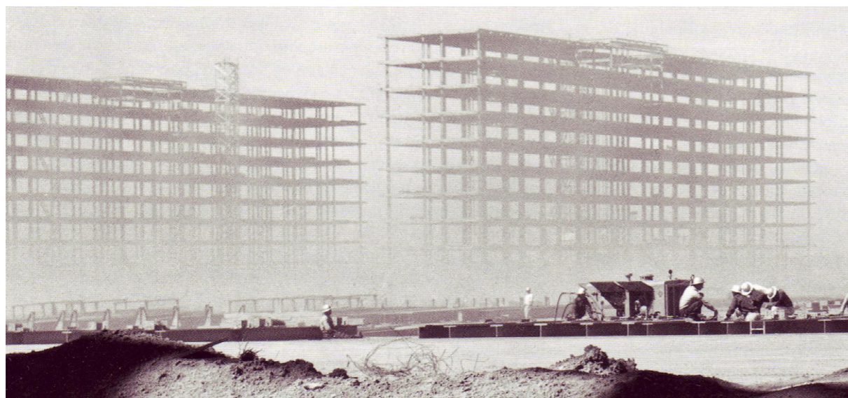
Esplanada dos Ministérios | Período de construção Foto do Arquivo DPHA
