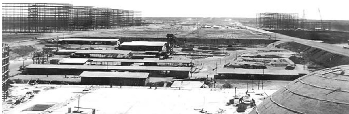
Eixo Monumental em construção | Vista da Esplanada dos Ministérios Foto do Arquivo Público de Brasília
