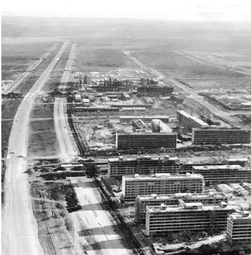
Início da construção do Congresso | Vista aérea Digitalização do Arquivo do DF
