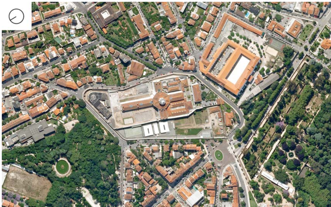
Figura 53 | Enquadramento urbano Penitenciária de Coimbra
