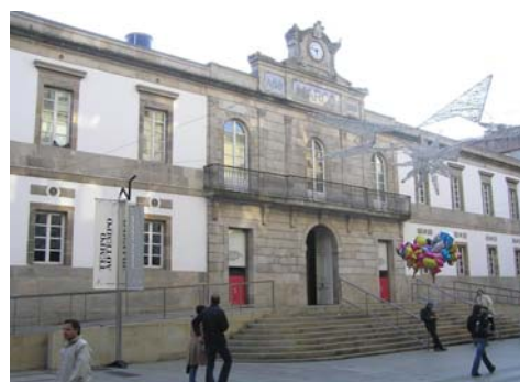
Figura 24 – Fachada do actual Museu de Vigo _ MARCO
