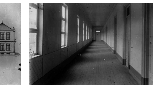
Fig.12 - Galeria de acesso às enfermarias (Arquivo fotográfico digital da Câmara Municipal de Vale de Cambra)
