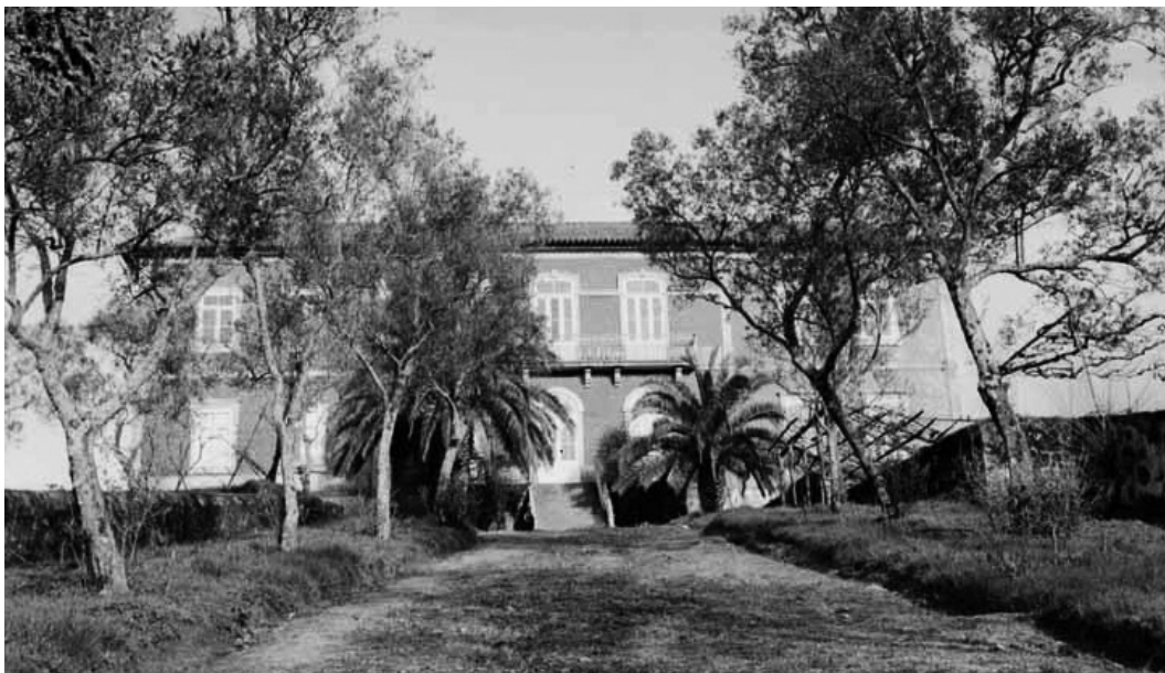
Fig.14 - Alameda de entrada para o Seminário (Arquivo fotográfico digital da Câmara Municipal de Vale de Cambra)
