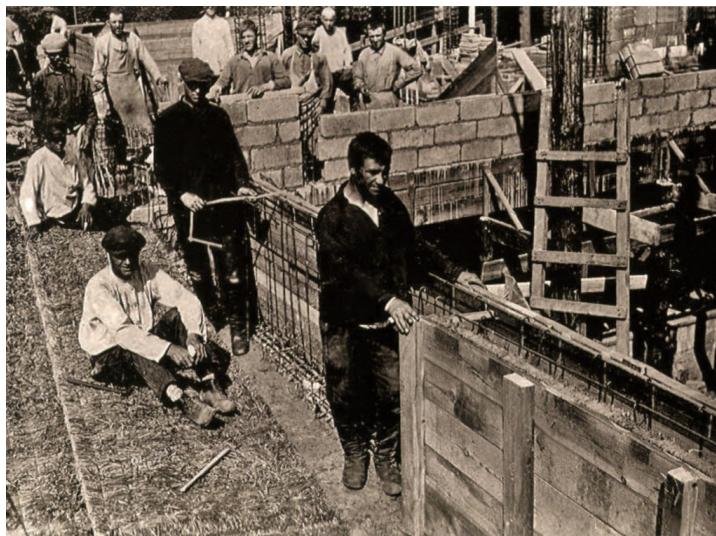
Fig.45. El Lissitsy - Edifício Narkofin , 1928-1930. Fotografia tirada durante a construção.
