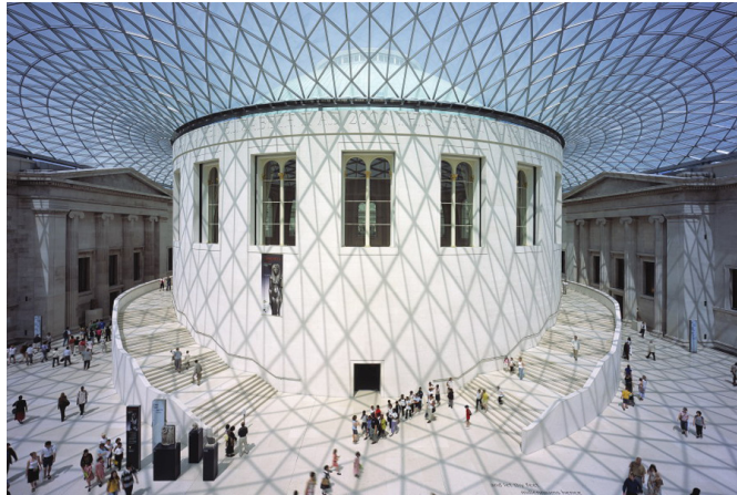
Fig.15. Norman Foster - The British Museum , Londres, Inglaterra (1994-2000). Imagem que demonstra a variação do padrão da cobertura. No caso particular deste projecto, os vidros são todos iguais, mas as peças que fazem de união são todas diferentes.
