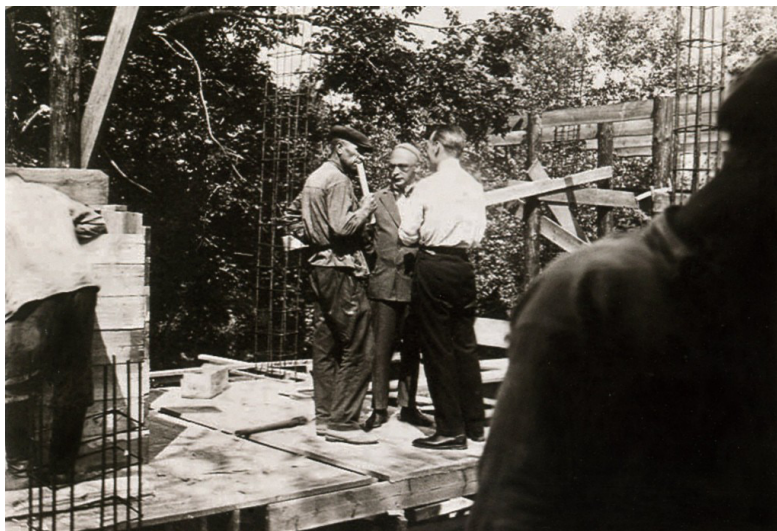
Fig.46. El Lissitsy - Edifício Narkofin , 1928-1930. Fotografia tirada durante a construção onde se vê o Arquitecto da construção a conversar com um construtor.
