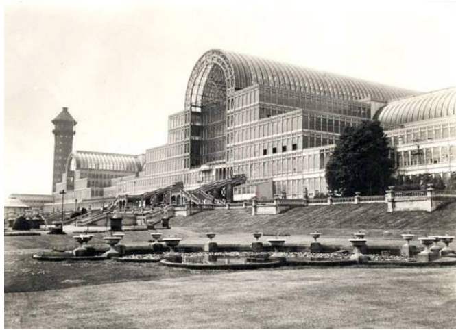
Fig.17. Joseph Paxton - Palácio de Cristal , Londres, 1851. Apesar de ser utilizada a construção de ferro e vidro, ainda se vê uma monumentalização do edifício.
