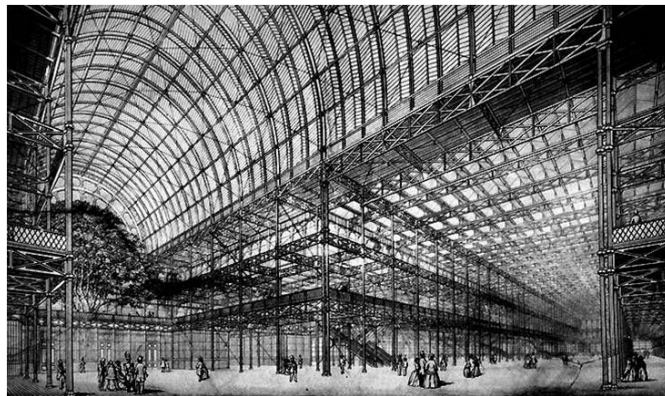
Fig.18. Joseph Paxton - Palácio de Cristal , Londres, 1851. Imagem do interior onde se distinguem os elementos estruturais..
