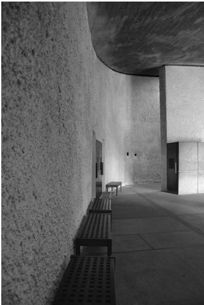
149| Parede Oeste interior
