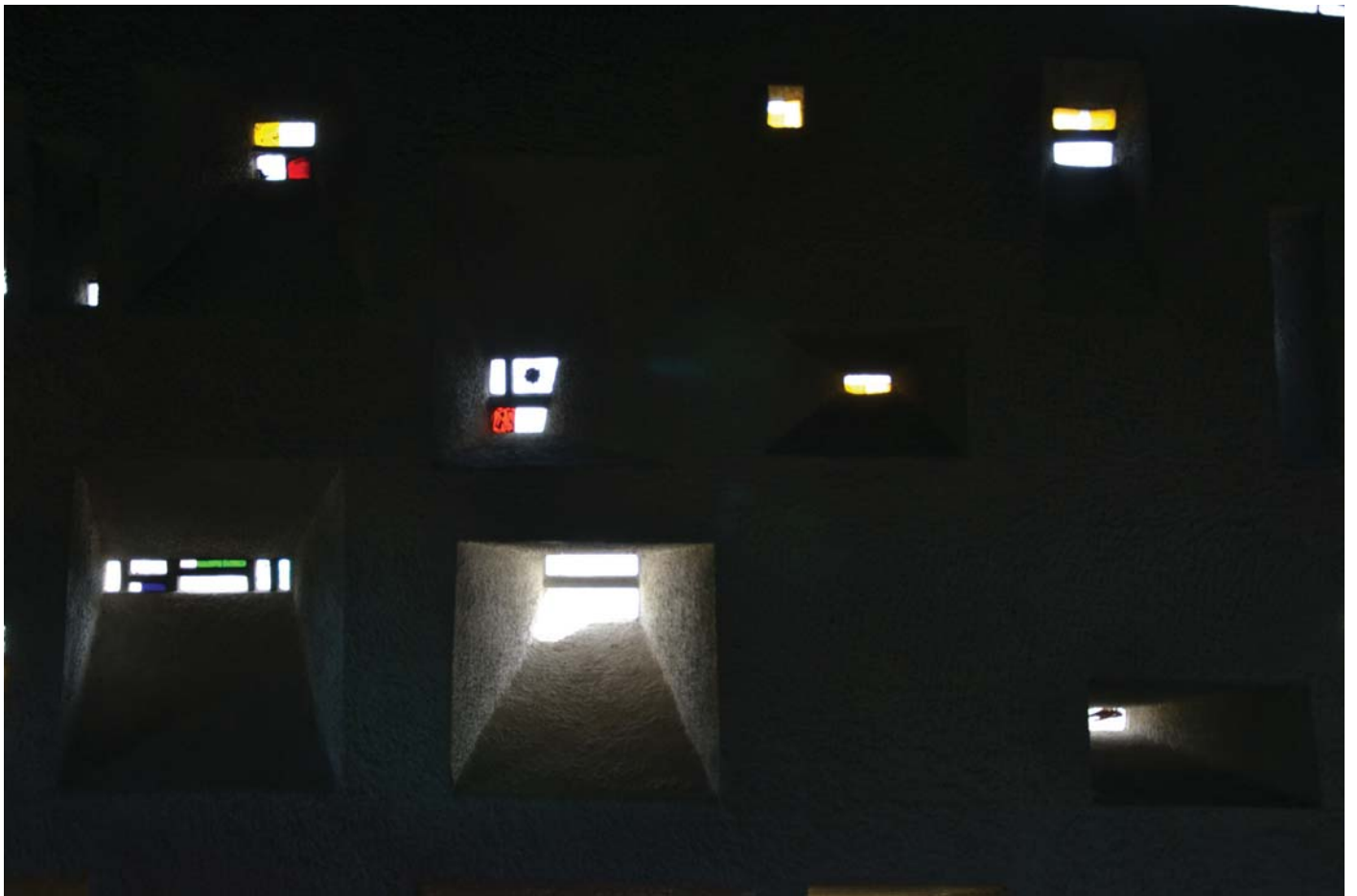
157| Alçado Sul interior
