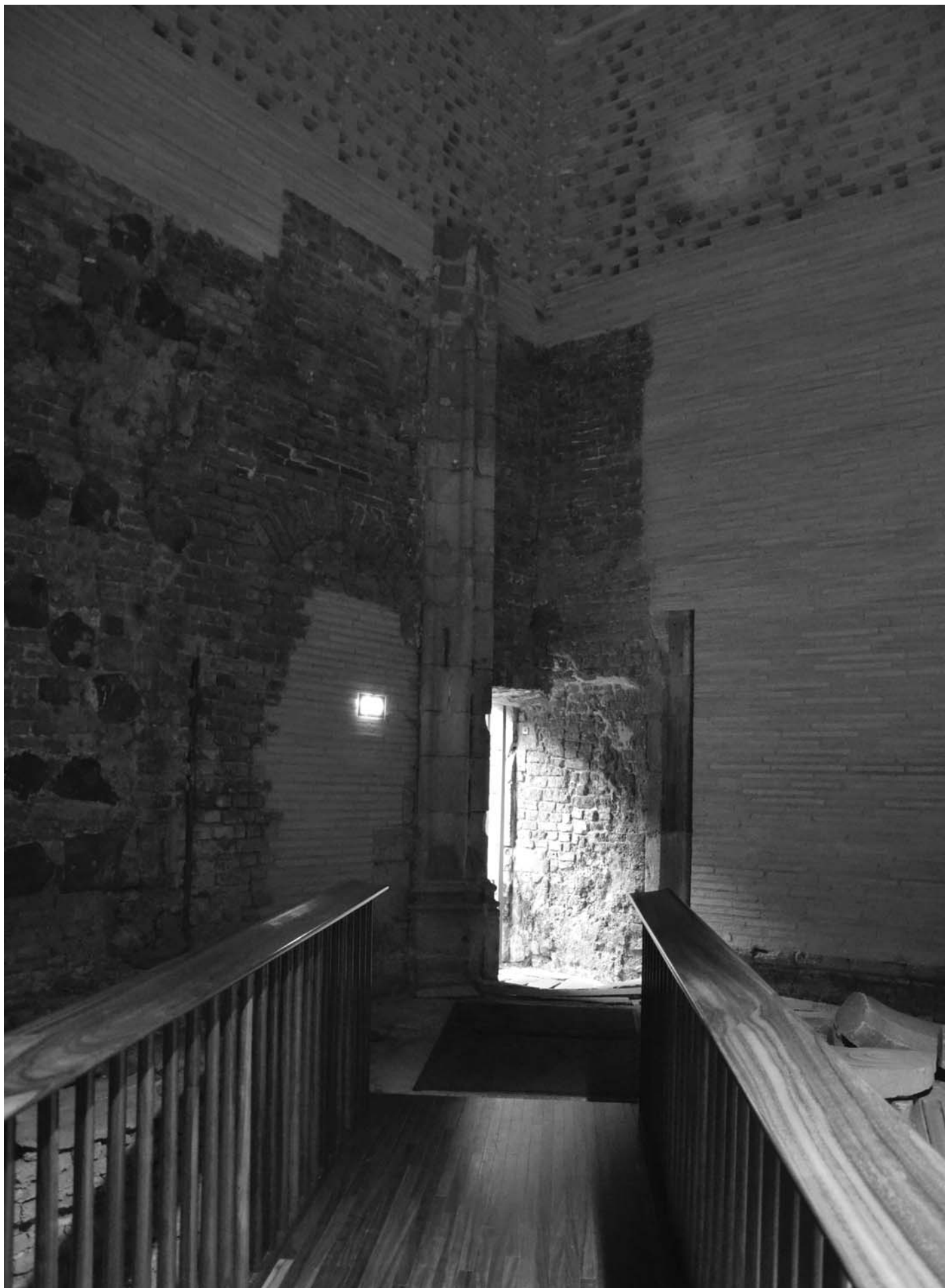
65| O passadiço que atravessa as ruínas e nos leva ao exterior.
