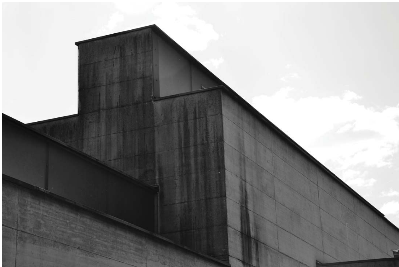
193| Pormenor da cobertura
