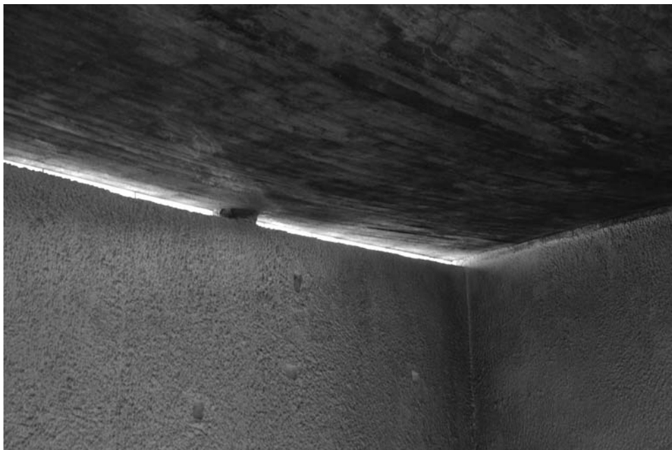
182, 183 e 184 | Pormenos tecto e paredes
