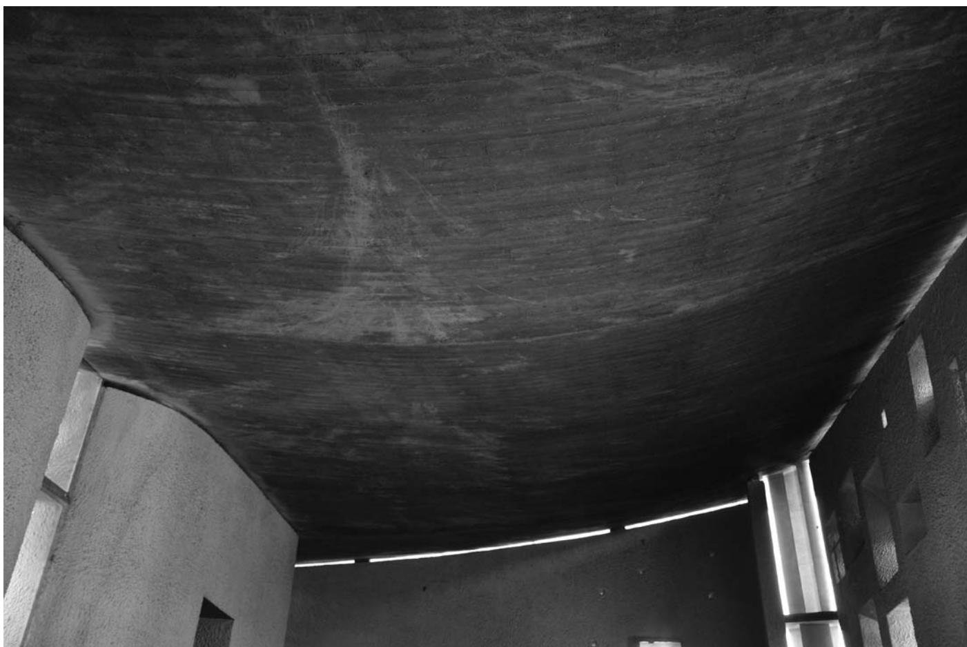
153|A cobertura de betão.
