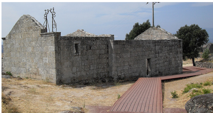
146. Requalificação da envolvente da Igreja de Santa Rita
