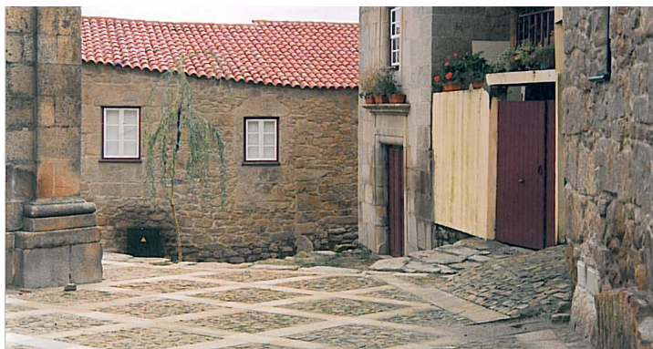
38. Infraestruturas de Castelo Mendo (pavimentação)
