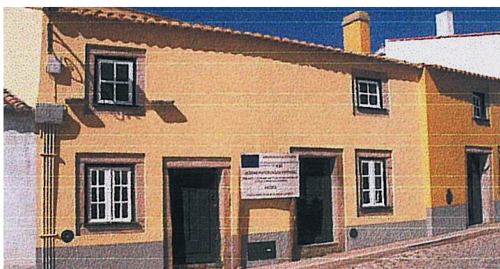
14. Recuperação de fachadas
