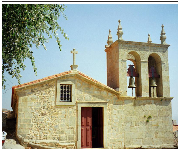
58. Igreja do Reclamador após a intervenção
