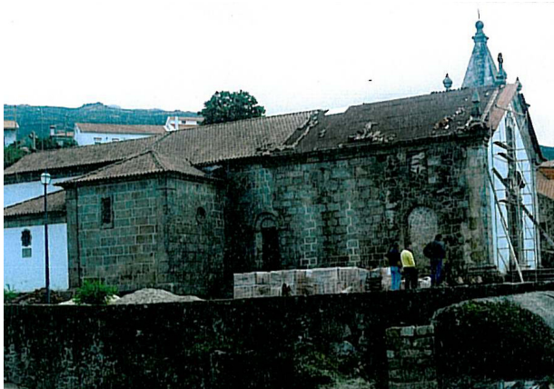
85. Igreja Matriz de Linhares antes da intervenção
