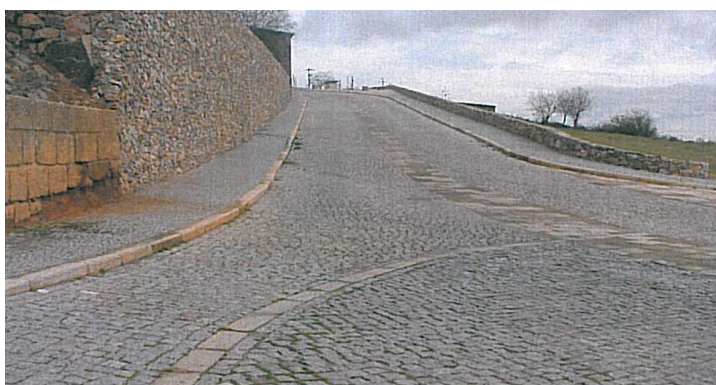
66. Acessos de Castelo Rodrigo após a intervenção
