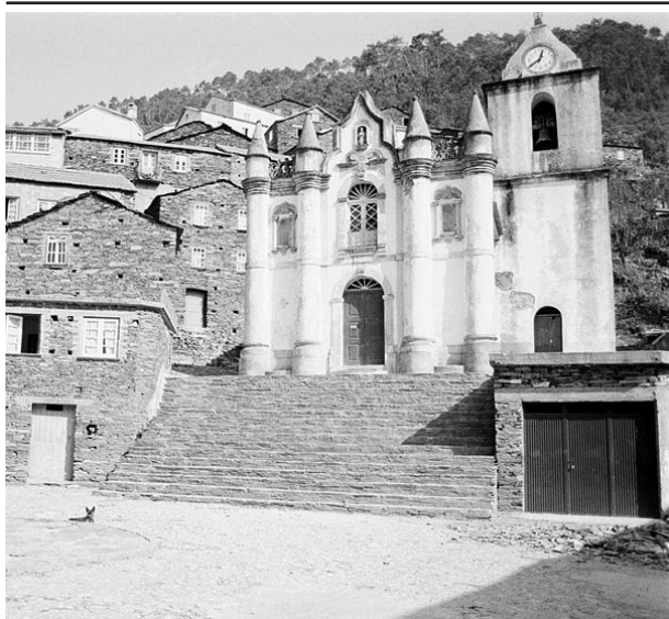
123. Igreja Paroquial do Piódão antes da intervenção
