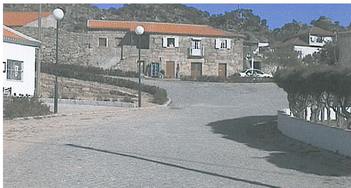
106. Pavimentação de arruamentos
