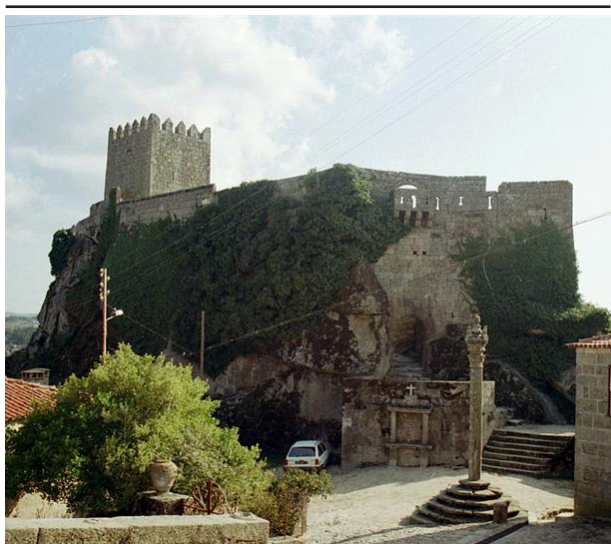
138. Castelo de Sortelha antes da intervenção
