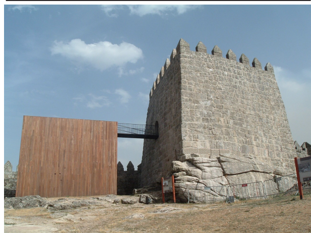
150. Castelo de Trancoso após a intervenção
