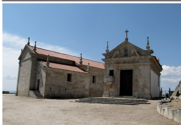
105. Igreja Santiago e Capela Sr. Passos após a intervenção
