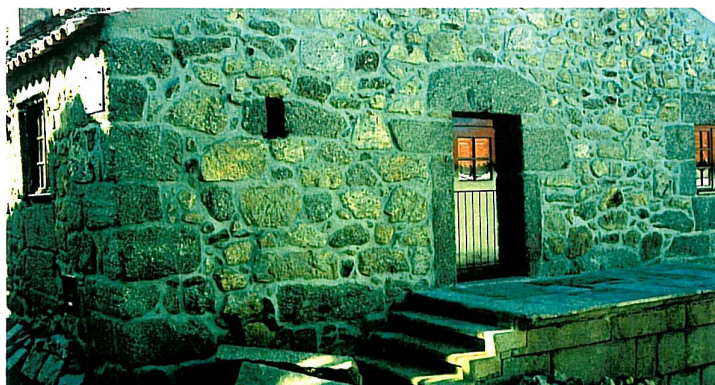
92. Recuperação de fachadas
