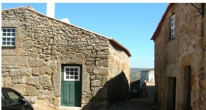
39. Recuperação de fachadas no Centro Histórico
