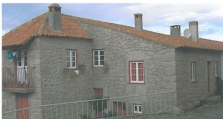
118. Recuperação de fachadas e coberturas
