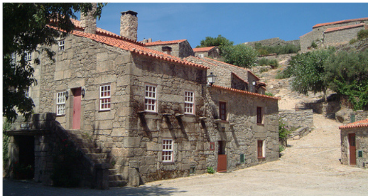
144. Recuperação de fachadas e telhados
