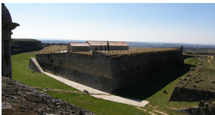
16. Recuperação do Antigo Paioi e Casa da Guarda
