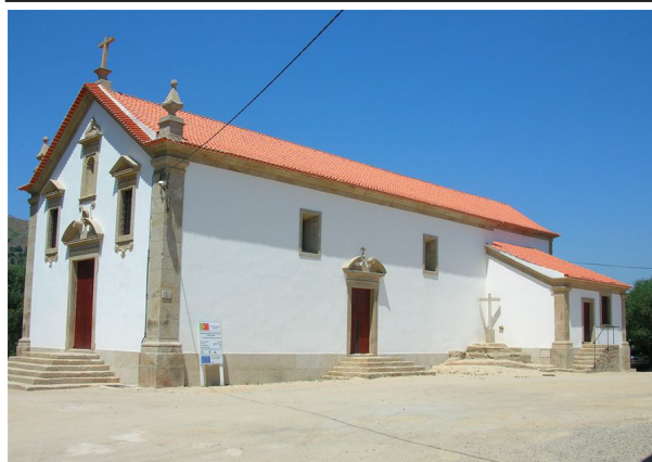
48. Igreja Matriz após a intervenção
