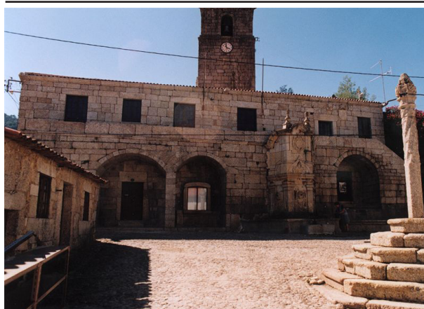
46. Edifício Antigos Paços do Concelho após a intervenção
