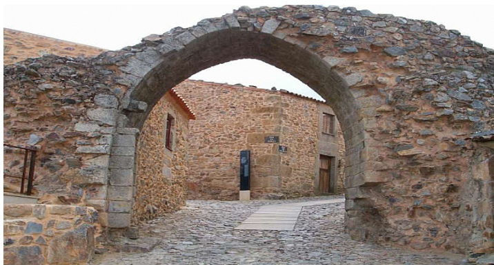
65. Troço de Muralha após a intervenção
