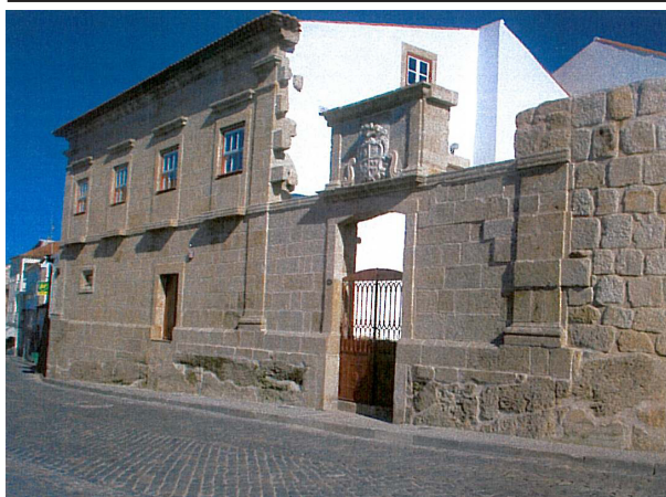
25. Solar dos Cabrais após a intervenção
