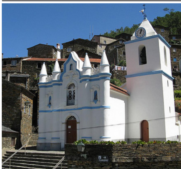
124. Igreja Paroquial do Piódão após a intervenção
