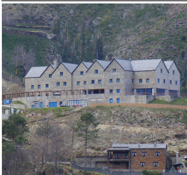
126. Pousada após a intervenção
