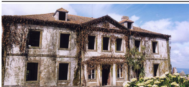
Registo Fotográfico antes da intervenção
