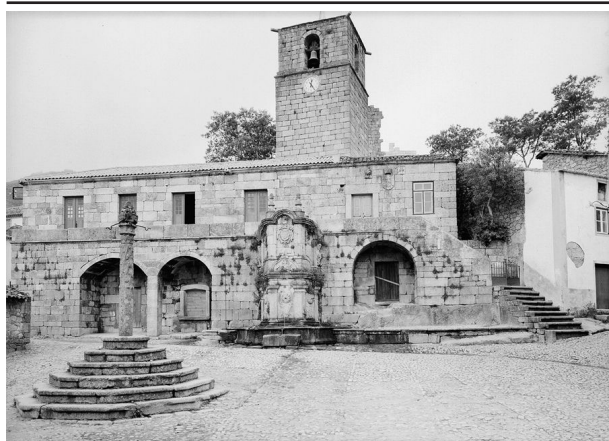
45. Edifício Antigos Paços do Concelho antes da intervenção
