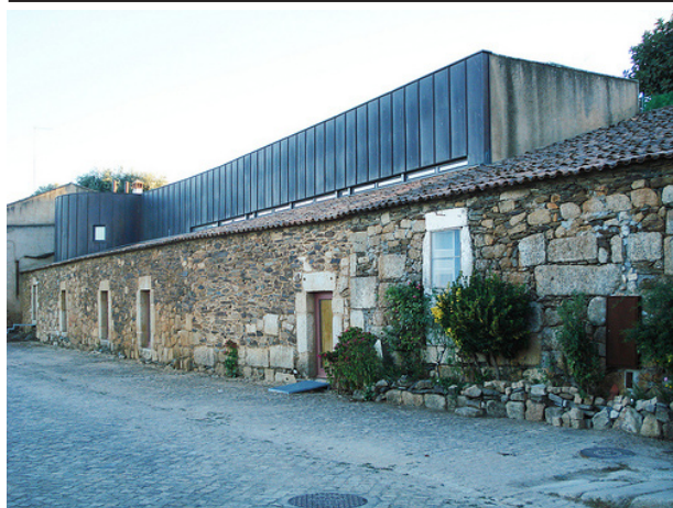
72. Palheiros de S. Dâmaso após a intervenção
