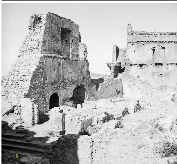
55. Palácio Cristóvão de Moura antes da intervenção
