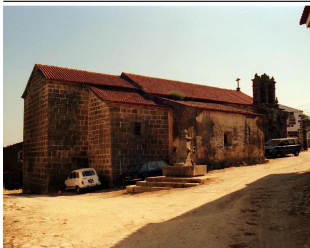
34. Igreja de S. Vicente antes da intervenção
