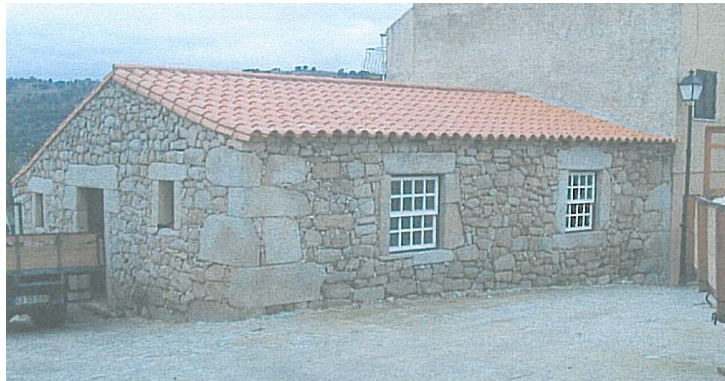
111. Recuperação de fachadas e coberturas
