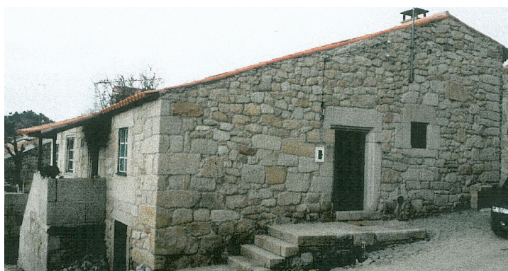
107. Recuperação de fachadas e coberturas
