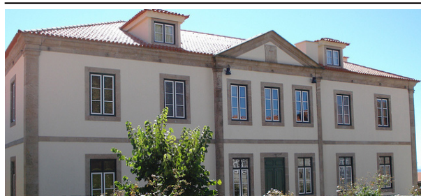
Registo Fotográfico após a intervenção
