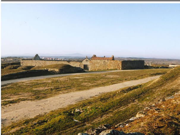
7. Vista geral do Picadeiro antes da intervenção
