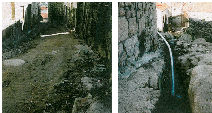
141. Infraestruturas no centro histórico
