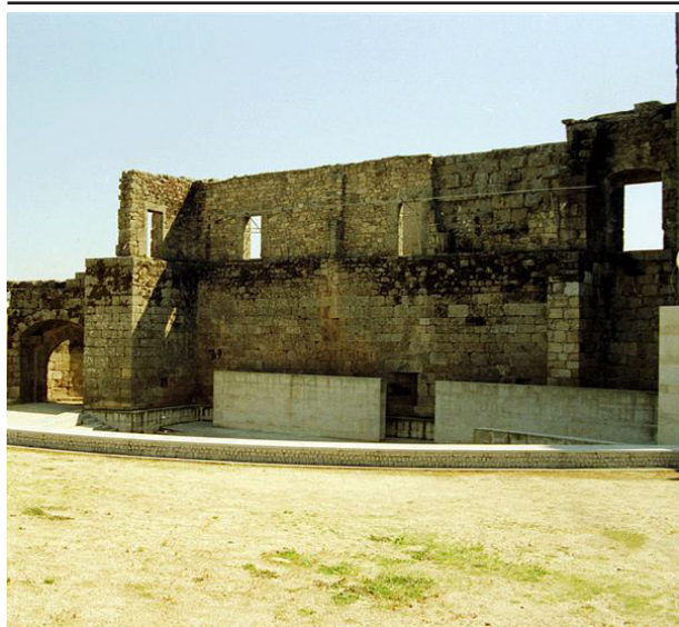
22. Vista do interior do Castelo antes da intervenção
