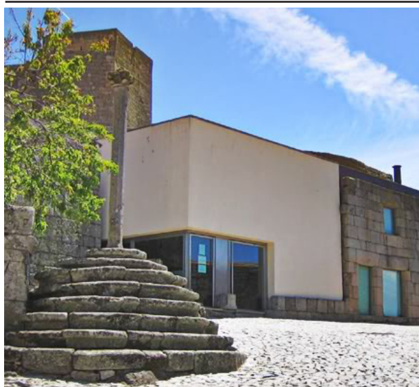
103. Posto de Acolhimento e Turismo após a intervenção
