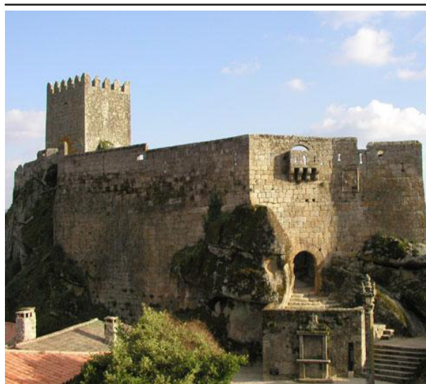
139. Castelo de Sortelha após a intervenção
