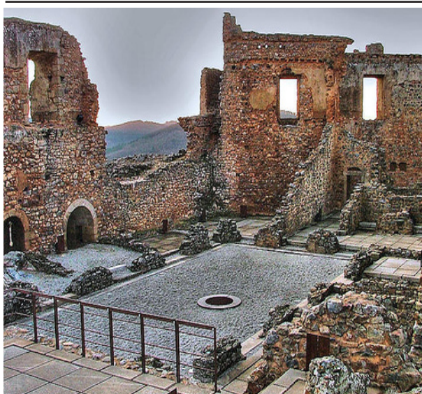
56. Palácio Cristóvão de Moura após a intervenção
