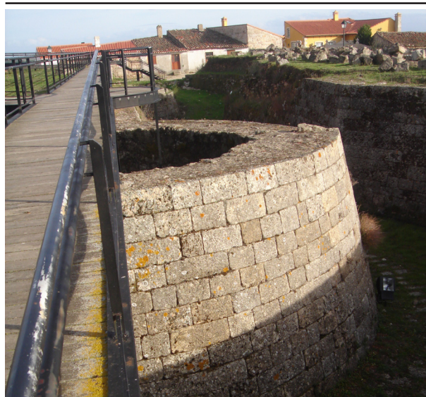
12. Vista das ruínas do Castelo após a intervenção
