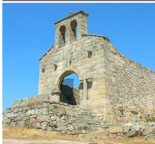
37. Igreja de Santa Maria do Castelo após a intervenção
