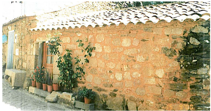
78. Recuperação de fachadas
