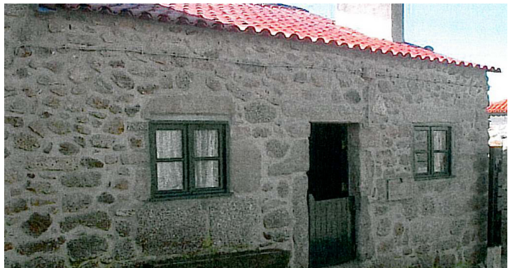
96. Recuperação de fachadas e coberturas
