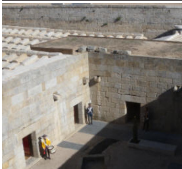
10. Vista das Casamatas após a intervenção
