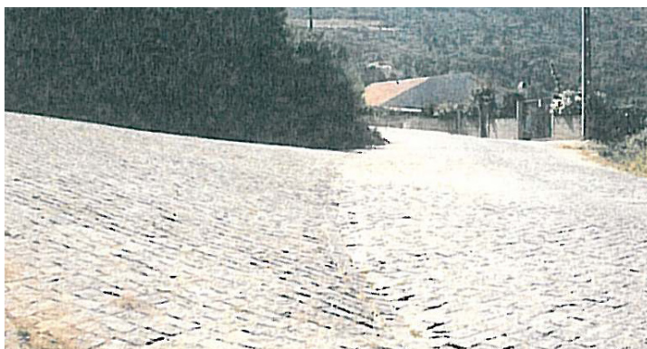
93. Pavimentação de arruamentos
