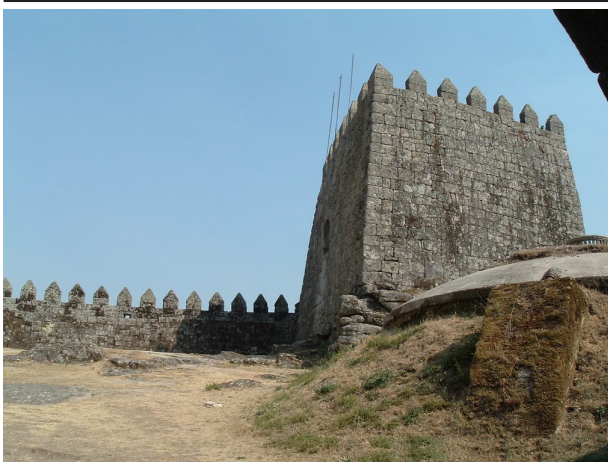
149. Castelo de Trancoso antes da intervenção
