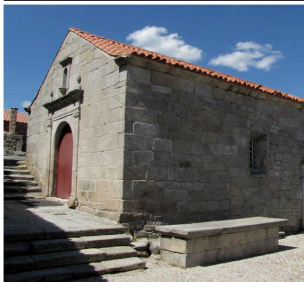
137. Igreja Matriz de Sortelha após a intervenção
