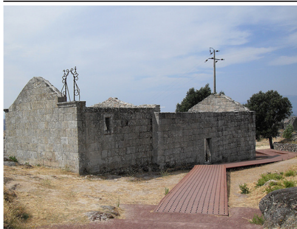
135. Igreja Santa Rita após a intervenção
