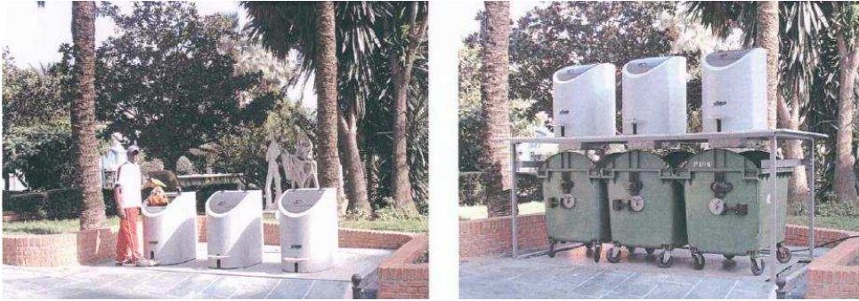
Figura 4.4: Sistema de ecopontos com elevação na vertical
