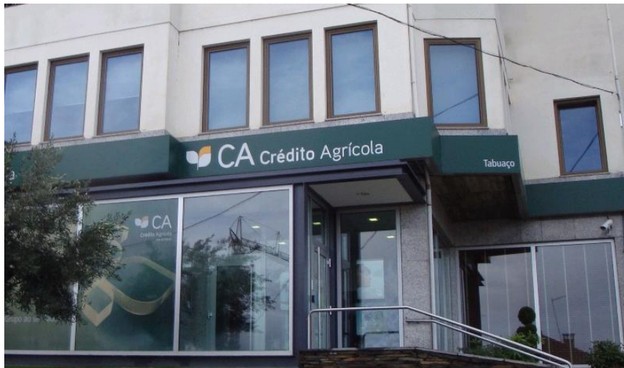
Ilustração 5: Instalações no exterior do local do estágio
