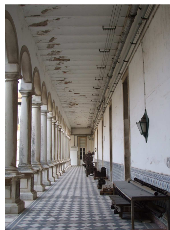
Ilustração 38 - Pormenor dos corredores que ladeiam o claustro
