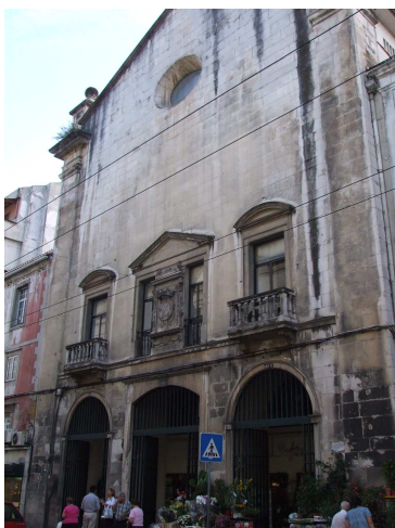
Ilustração 19 - Fachada da Igreja de São Domingos
