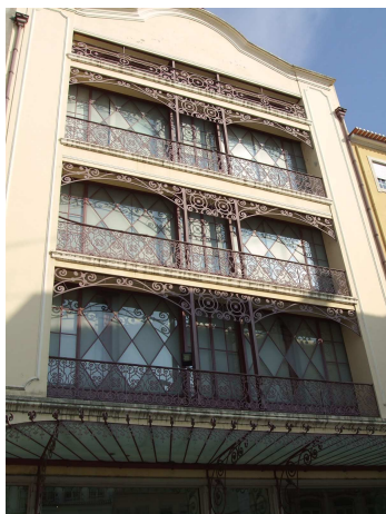
Ilustração 80 Fachada do Edifício do Chiado
