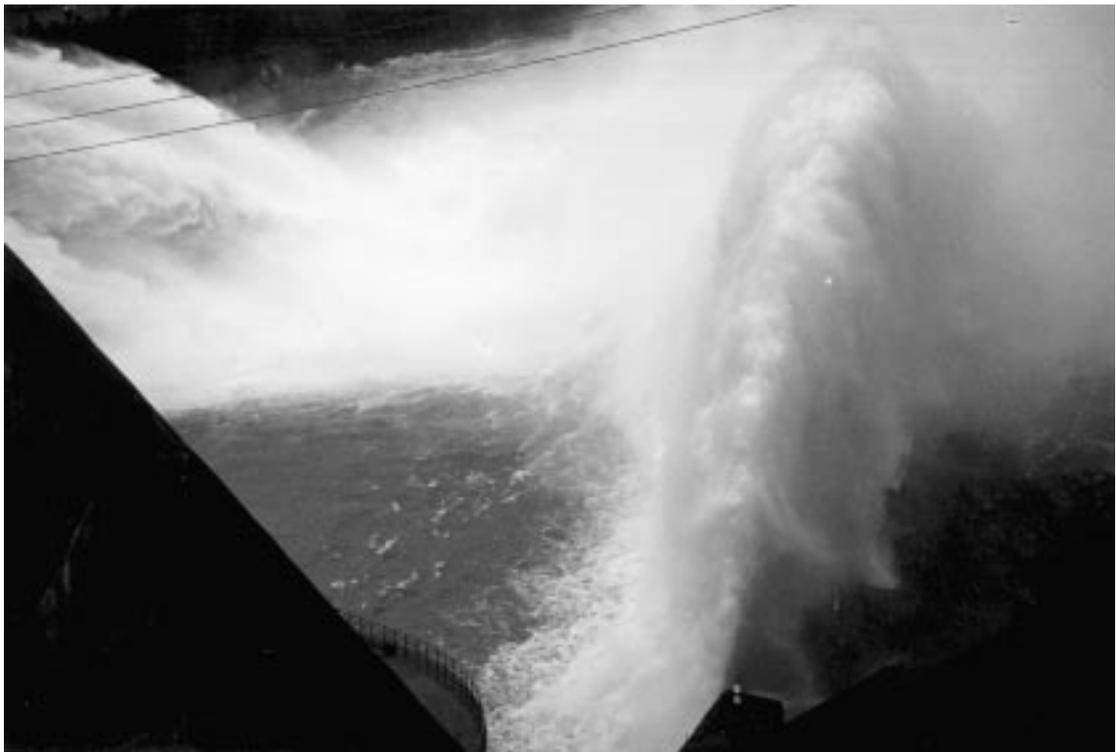
Foto 7 – Pormenor da intensa descarga (1100 m<sup>3</sup>/s) pela barragem da Aguieira (foto de M. Morais, na tarde de 27/01/2001).
