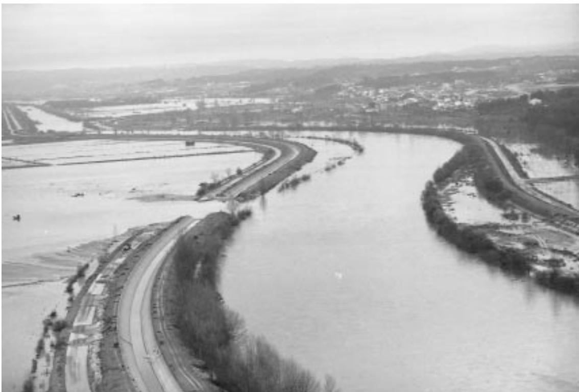
Foto 14 – Panorâmica da ruptura no dique direito do Canal Principal, junto de Santo Varão (foto de A. Carriço, 30/01/2001), permitindo observar o contorno do derrame de areia.
