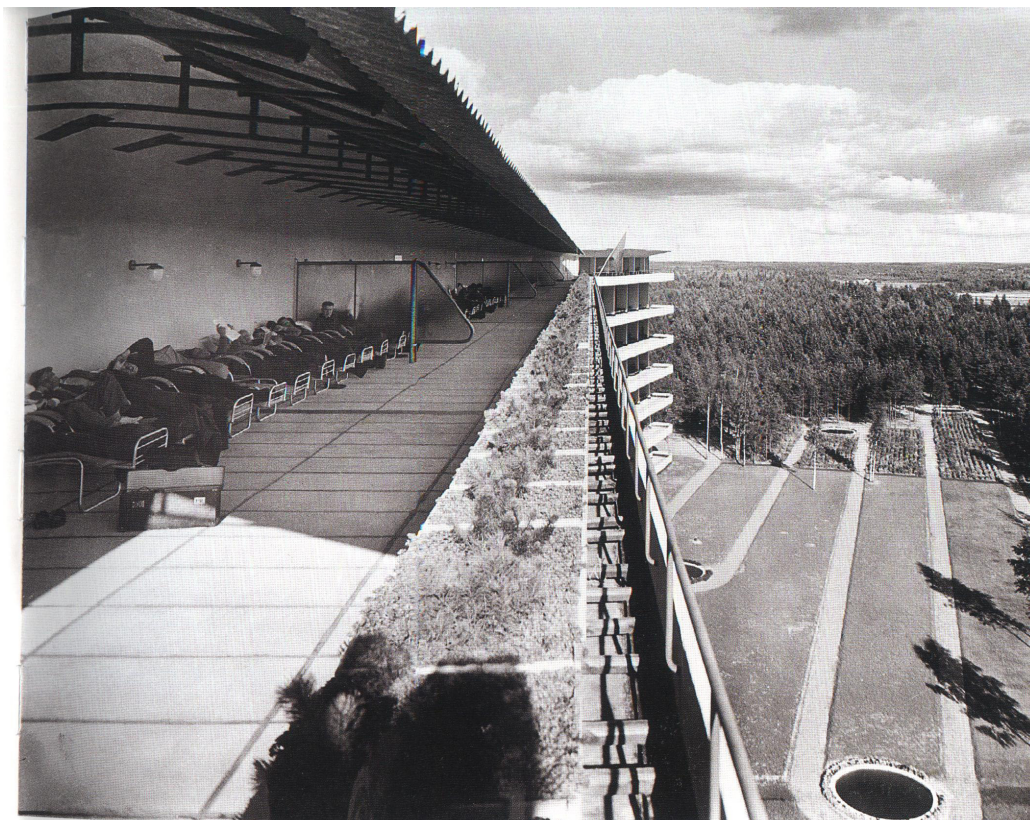
fig. 33 | Sanatório de Paimio (1928-1933), Finlândia. Alvar Aalto.
