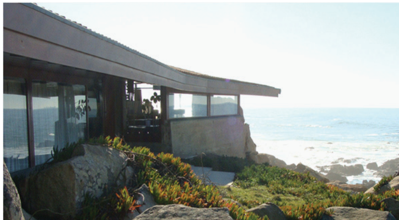
FIG 22 Casa de Chá, Álvaro Siza Vieira.
