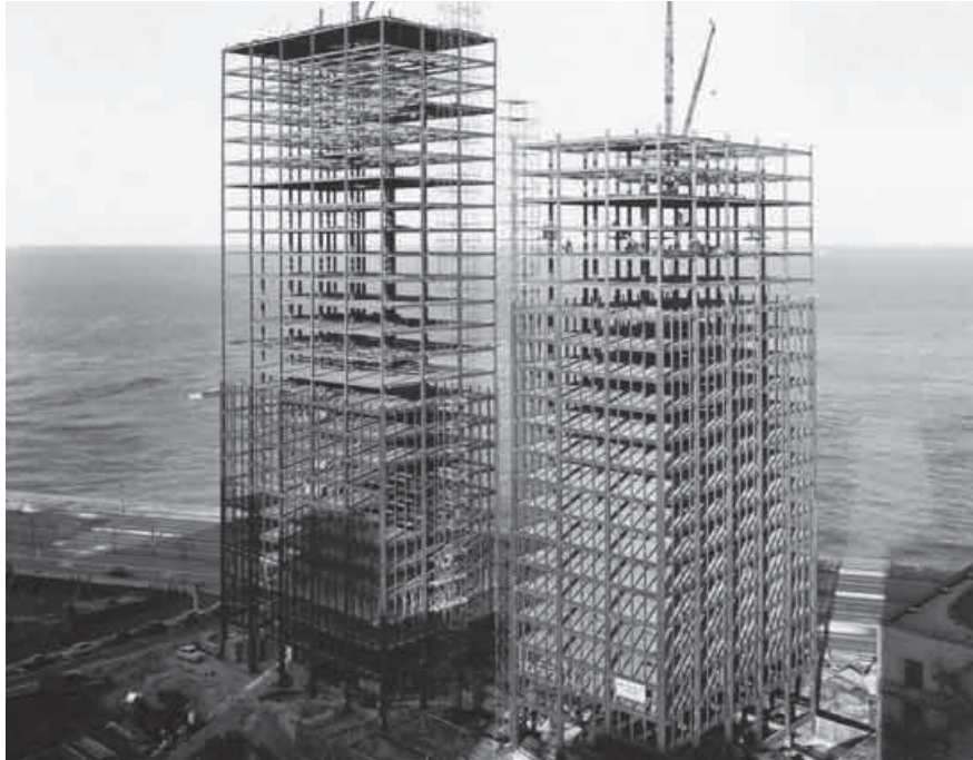
FIG 33 Construção dos edifícios de Lake Shore Drive. Ano??
