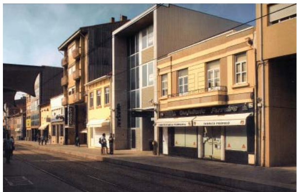
[25] O novo edifício desenhado por Alcino Soutinho para a rua Brito Capelo
