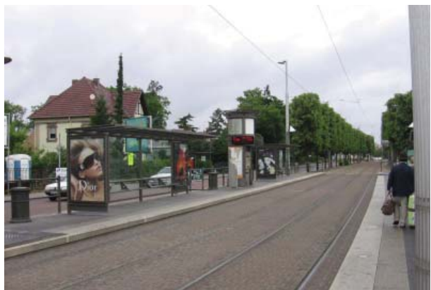
[48]–[51] A via de metro de superfície – Estrasburgo
