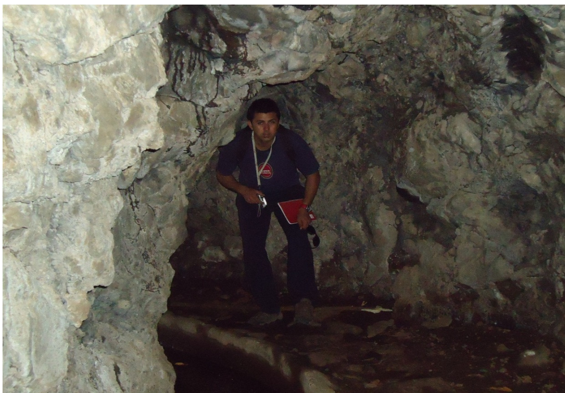
Figura 12 – Túnel Levada do Caldeirão Verde
