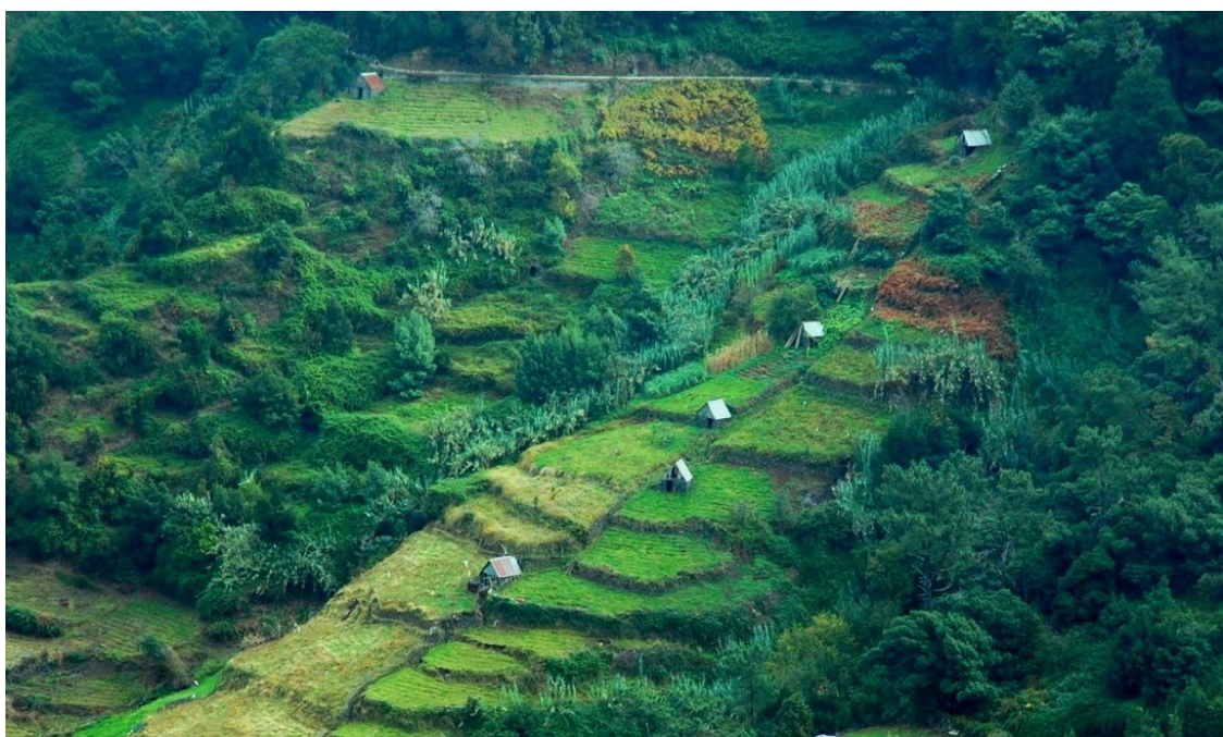
Figura 3 - Solos Armados em Socalcos
