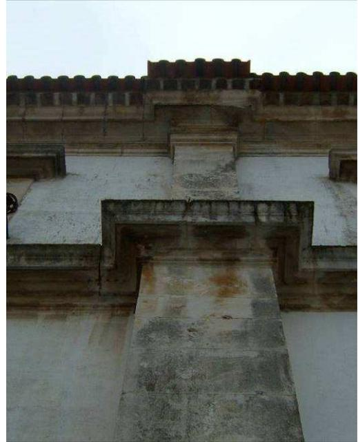
Imagens 201 e 202 – Fachada principal onde se nota na primeira fotografia a necessidade da pilastra disfarçar o desalinhamento ou quebra no pano de parede existente.
