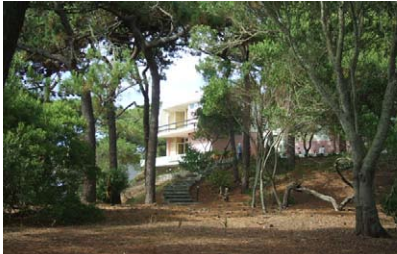
Fig. 83. Casa João Simões. Vista da moradia entre a arborização.
