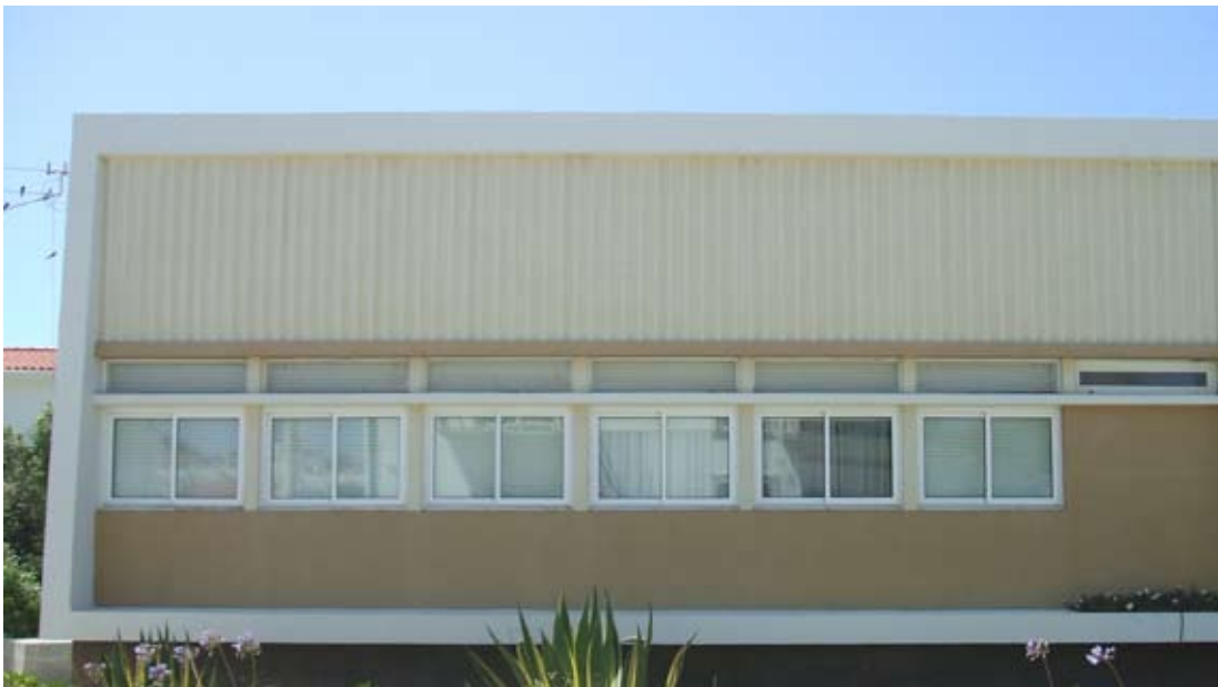
Fig. 124. Casa José Malta. Placas de "lusalite" na fachada a Este.
