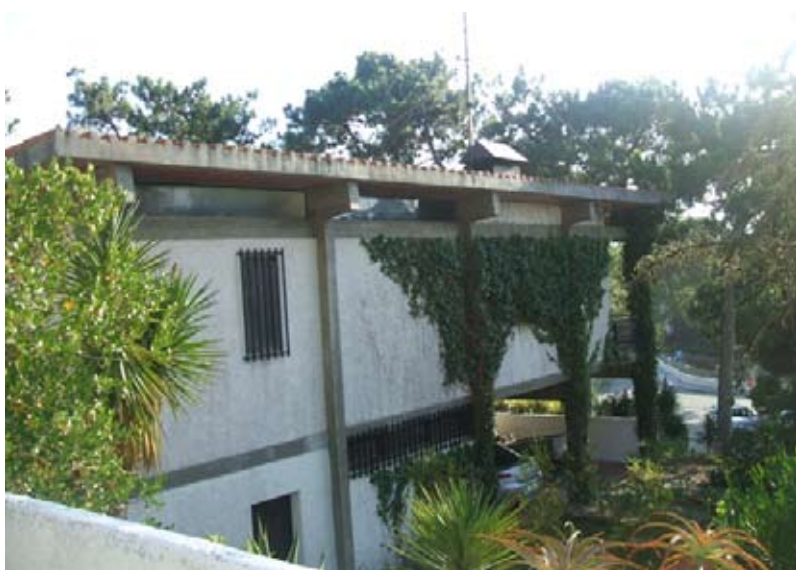
Fig. 162. Casa Ernesto Borges. Pilotis "camuflados" na fachada lateral.
