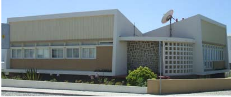
Fig. 108. Casa José Malta. Volume à esquerda - zona íntima e volume à direita - zona social.
