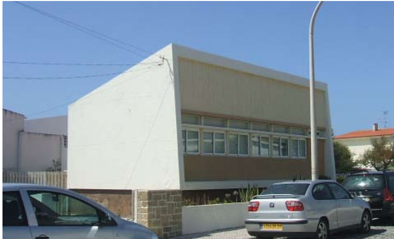
Fig. 44. Casa José Malta. Placas de “lusalite” aplicadas na fachada Este.
