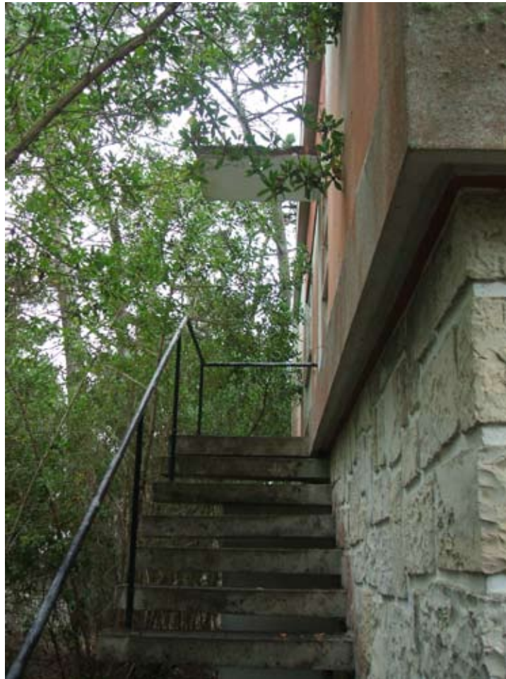
Fig. 92. Casa Joaquim Byrne. Escada de serviço.
