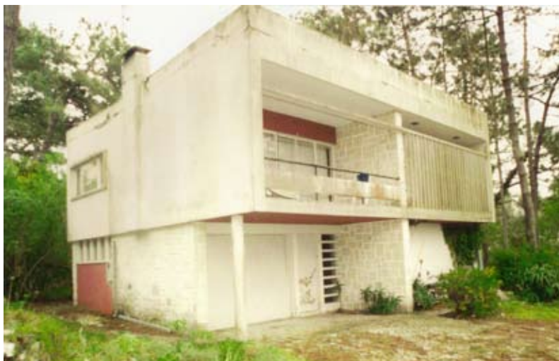
Fig. 118. Casa Joaquim Byrne. Grandes envidraçados entre a sala e varanda.
