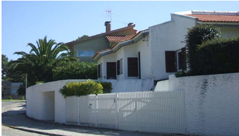
Fig. 167. Casa Waltrand Franz. Entrada/embasamento da moradia.
