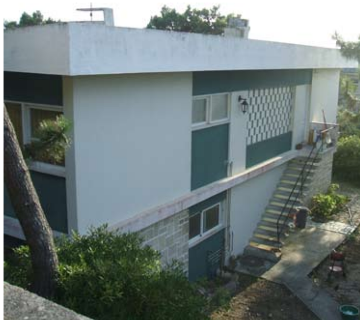
Fig. 93. Casa Joaquim Lourenço. Escada de serviço.
