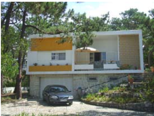
Fig. 132. Casa João Franco Frazão. Grelha na Fachada principal.
