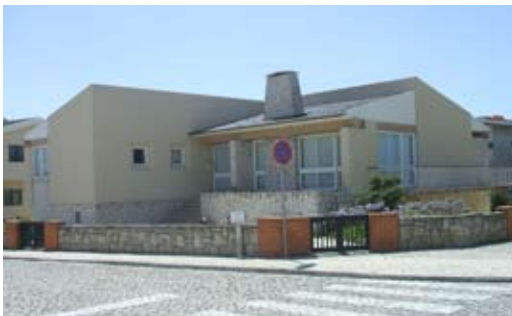
Fig. 141. Casa Floriano Arede.
