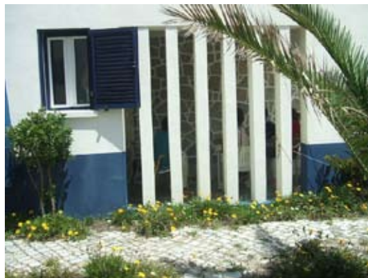
Fig. 133. Casa Luiz Olavo Oliveira. Lâminas verticais em betão na fachada lateral.
