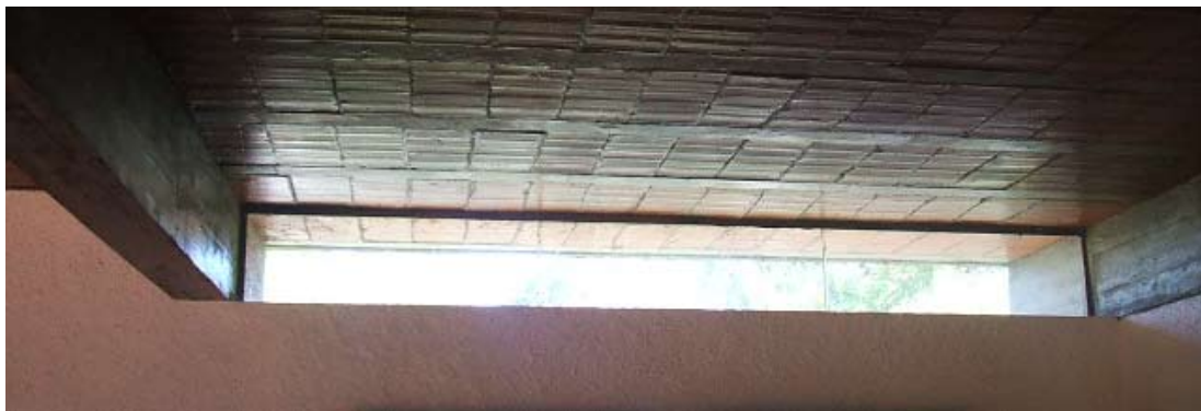
Fig. 159. Casa Ernesto Borges. Vigamento aparente na sala comum.
