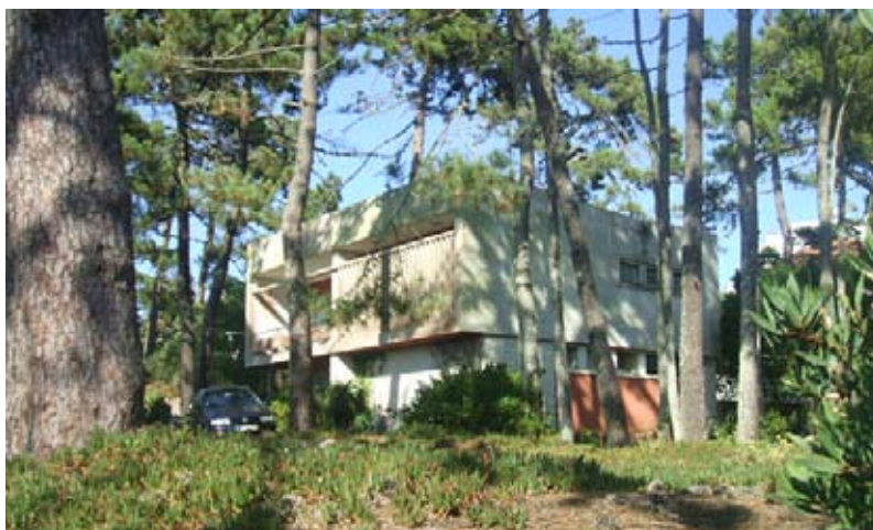
Fig. 84. Casa Joaquim Byrne. Vista da moradia entre a arborização.
