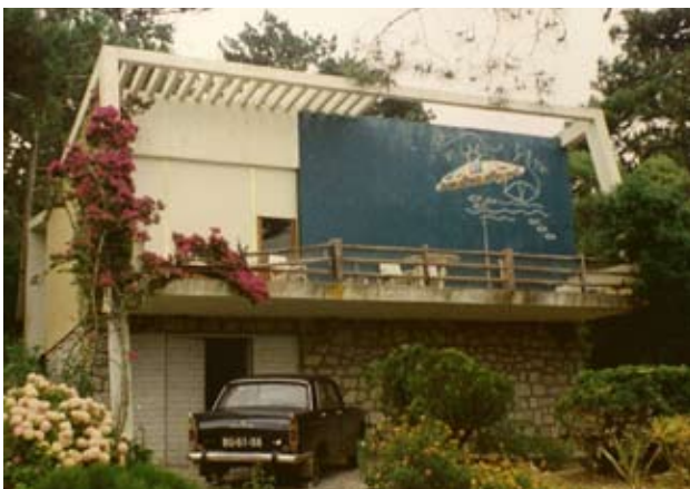
Fig. 116. Casa Manuel Augusto Rosa. Representação de uma paisagem na fachada principal.
