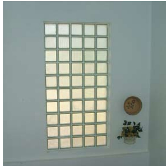
Fig. 128. Casa Mª Filomena Carrega. Tijolo de vidro na zona das escadas.
