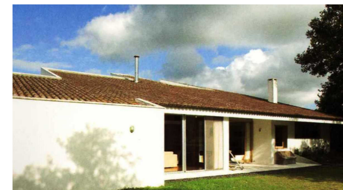
Fig. 6, 7 e 8 | Terraço; corredor do piso 0; alçado do corredor dos quartos
