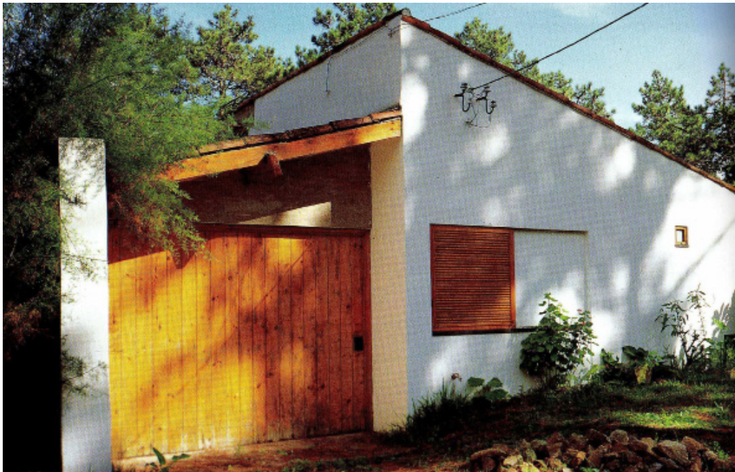
Fig. 49 | Entrada para a garagem, fachada Poente.
