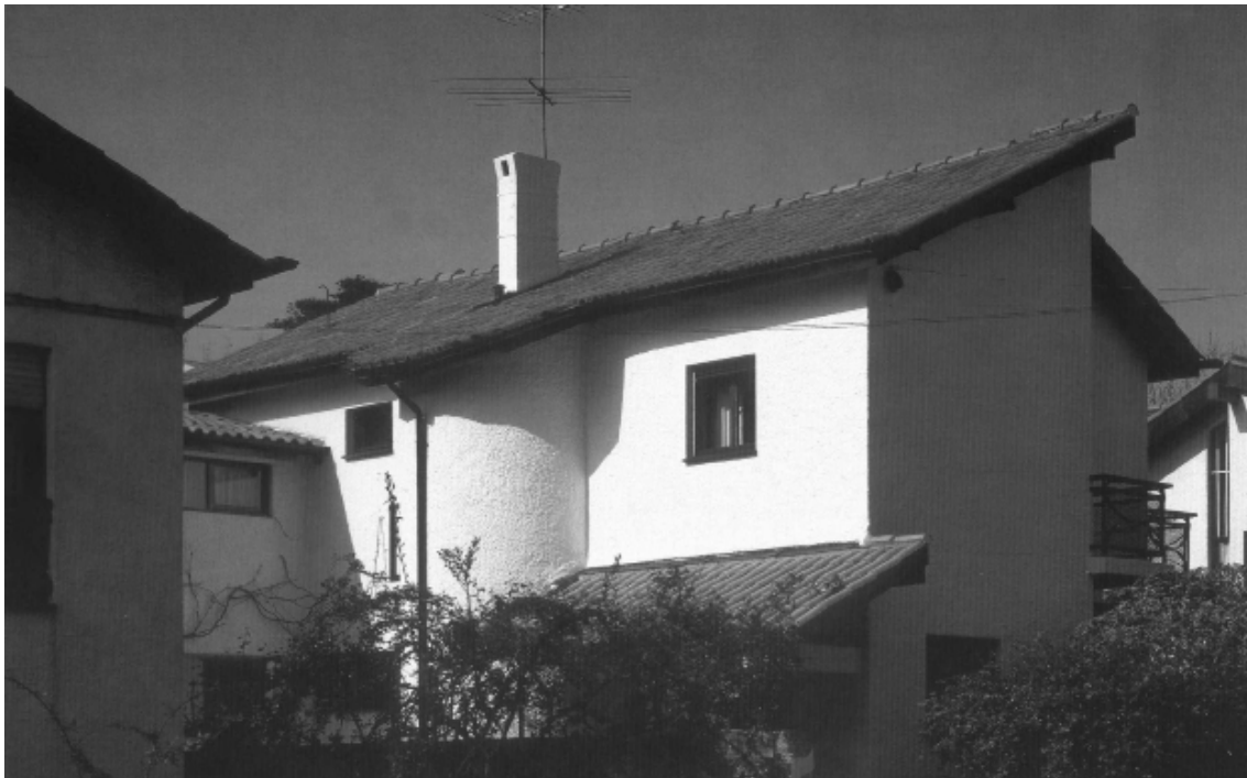
Fig. 74 | Quatro Casas, casa do meio, Matosinhos, 1954, Álvaro Siza Vieira.
