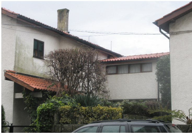
Fig. 95 | Corpo da garagem e jardim da entrada da Casa do meio.
