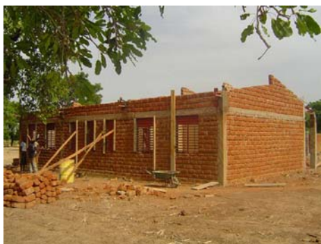
Fig. 36 - Colocação das janelas.
