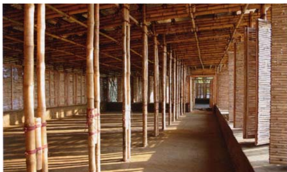
Fig. 61 - Piso superior com estrutura e paramentos em bambu.
