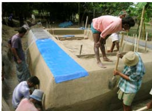
Fig. 59 - Barreira impermeável numa casa particular, técnica semelhante à METIschool.
