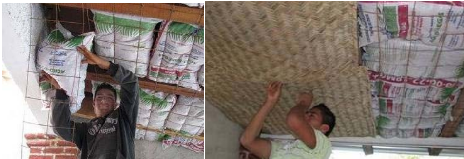
Fig. 57 - Isolamento interior em sacos com casca de arroz.
