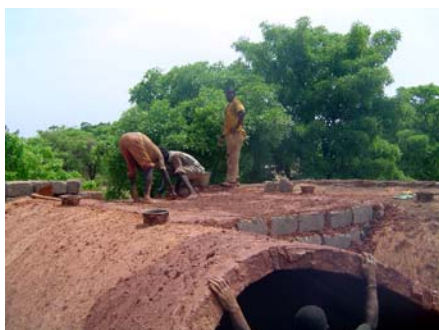
Fig. 26 - Construção da abobada núbia.
