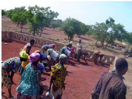
Fig. 28 - Compactação da cobertura.
