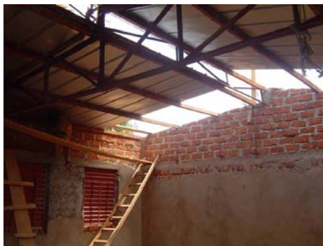
Fig. 38 - Fixação da chapa metálica.
