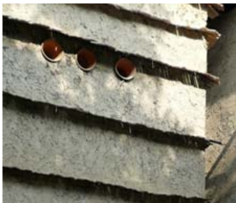
Fig. 68 - Ripas de bambu encastradas na parede que previnem a sua erosão pluvial
