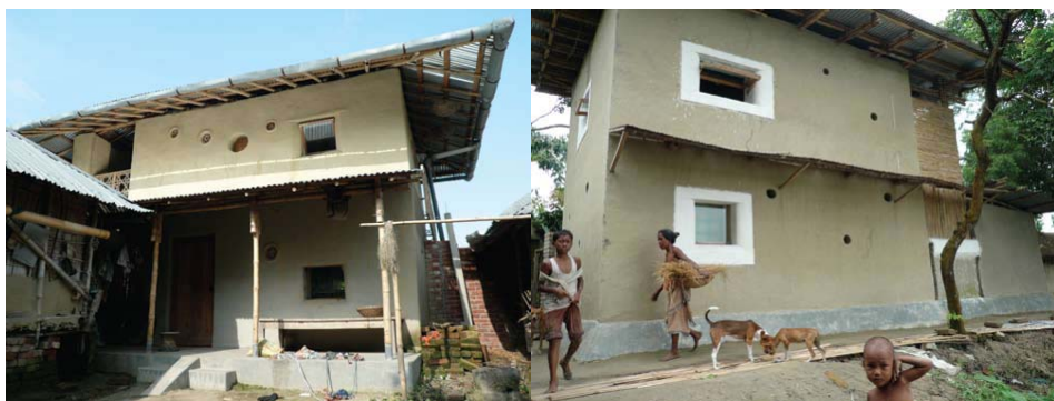
Fig. 64 - Duas das três casas construídas em Rudrapur e Vishnipur, Bangladesh.
