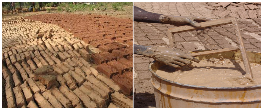
Fig. 22 - Preparação do adobe e fabrico dos blocos.
