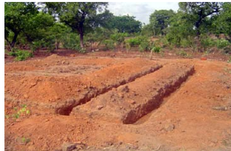
Fig. 31 - Traçado e escavação das fundações.
