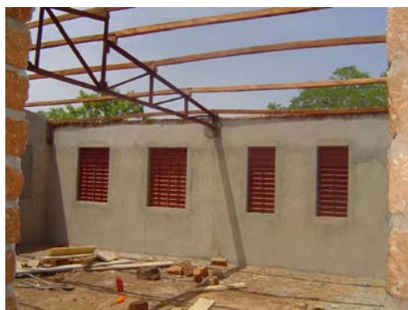
Fig. 37 - Montagem da treliça e das madres.
