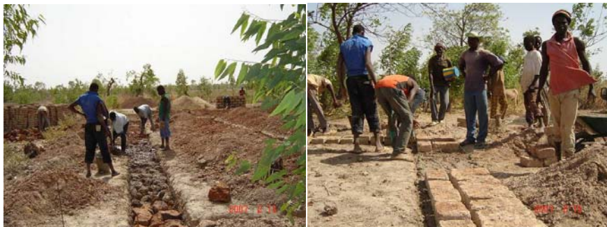
Fig. 23 - Escavação e enchimento da vala de fundação.
