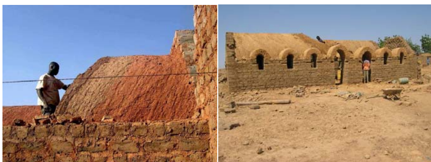
Fig. 25 - Construção das abóbadas.
