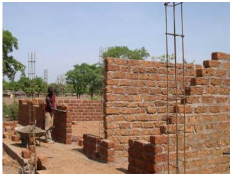
Fig. 34 - Construção das paredes.
