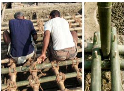
Fig. 60 - Construção do pavimento do 1º piso numa casa particular, semelhante à METIschool.
