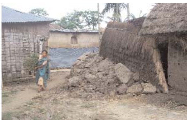
Fig. 53 - Parte de uma casa em terra desmantelada.
