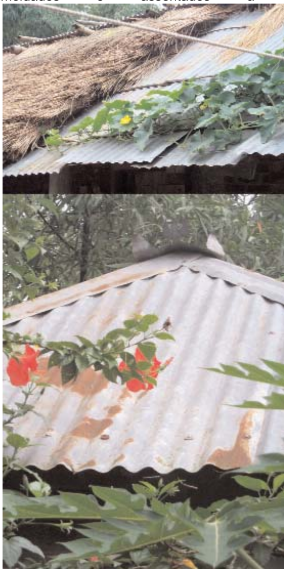
Fig. 55 - Telhados em palha ou em chapa ondulada
