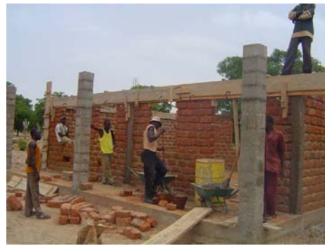
Fig. 35 - Construção das vigas.
