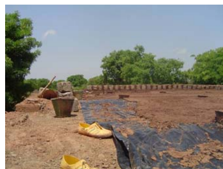
Fig. 27 - Impermeabilização da cobertura.
