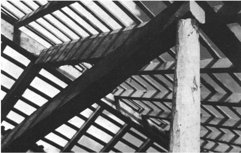
29 | Construção de um Telhado em Canas de Senhorim
