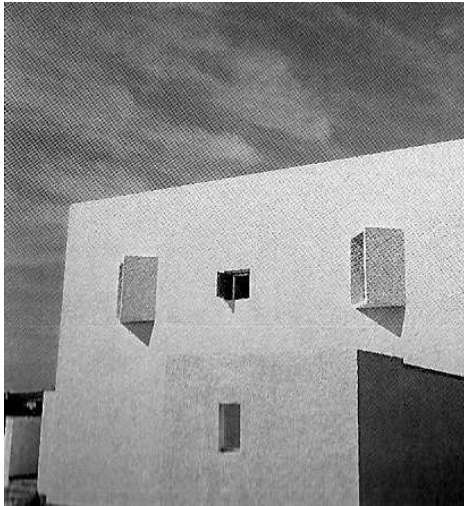
104 | Pormenor do alçado Norte da Casa de Albarraque
