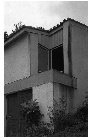
130 | Pormenor do Canto da fachada da Casa do Freixial
