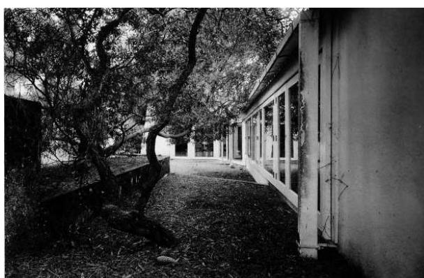
93 | Aberturas para o pátio da Casa Alves Costa
