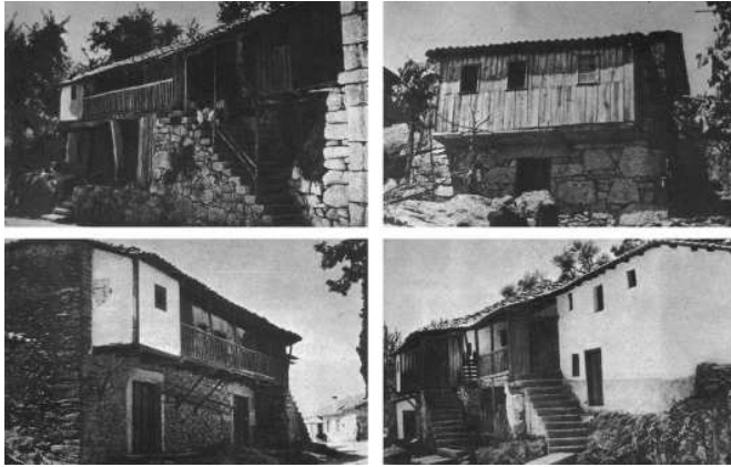
56 | Galerias de madeira em habitações em Celorico de Basto, Monção e Cinfães
