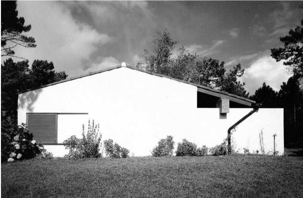
132 | Fachada Sul da zona dos quartos da Casa de Ofir
