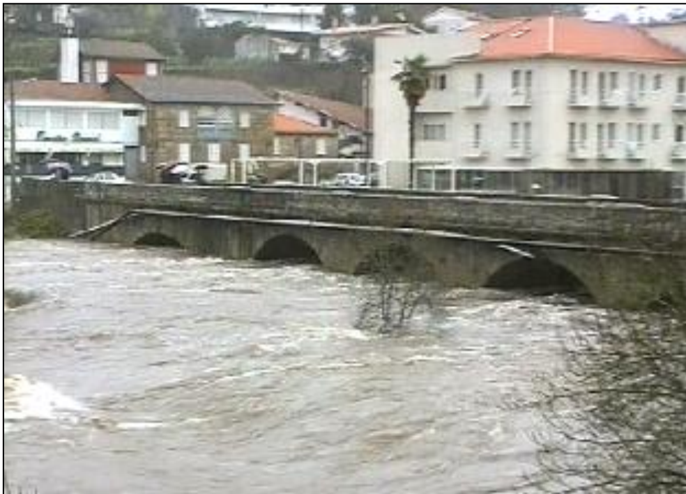
Foto 7 - Inundação nas Termas de S. Pedro do Sul, 7 de Dezembro de 2000.
