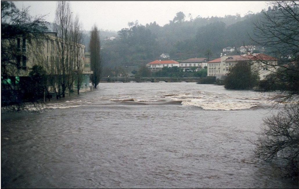
Foto 6 - Inundação nas Termas de S. Pedro do Sul. 7 de Dezembro de 2000.
