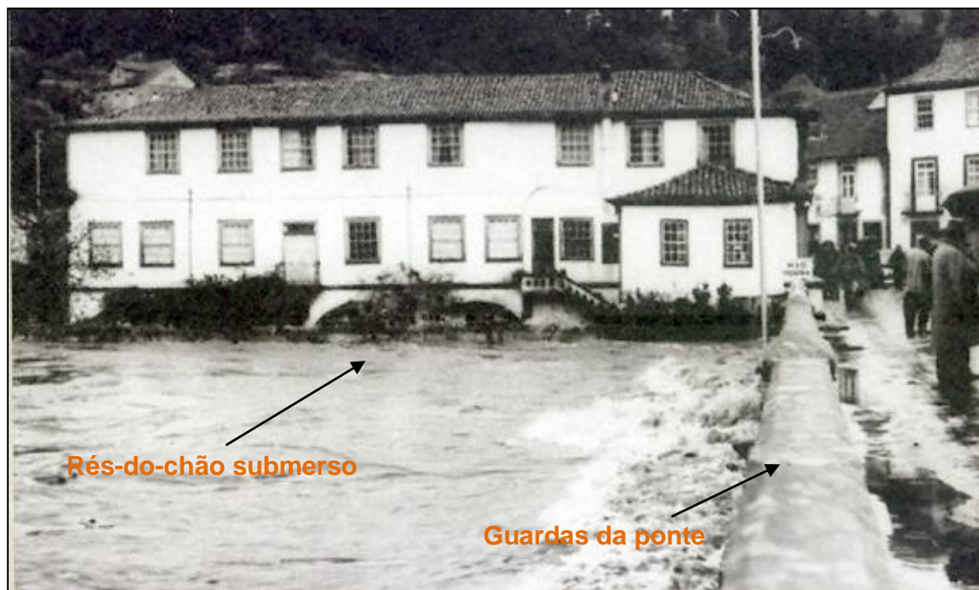
Foto 1 - Pensão Santos, actual Hotel Rural Villa do Banho, 15 de Novembro de 1963
