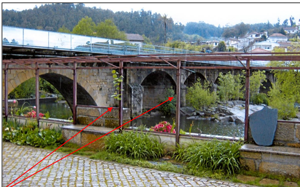
Estrutura metálica onde são colocadas placas em madeira de navio.
