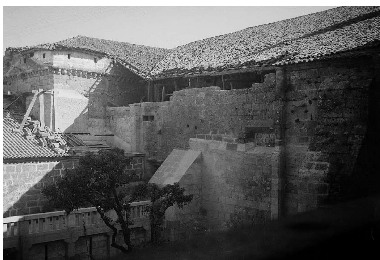
Fig. 14 – Restauro da caixa de escada Seiscentista que comunica com o coro alto. DGEMN
