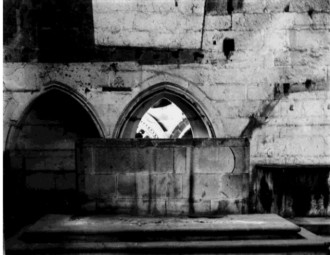
Fig. 19 – Arcos ogivais descobertos após a retirada da Capela do Espírito Santo. DGEMN
