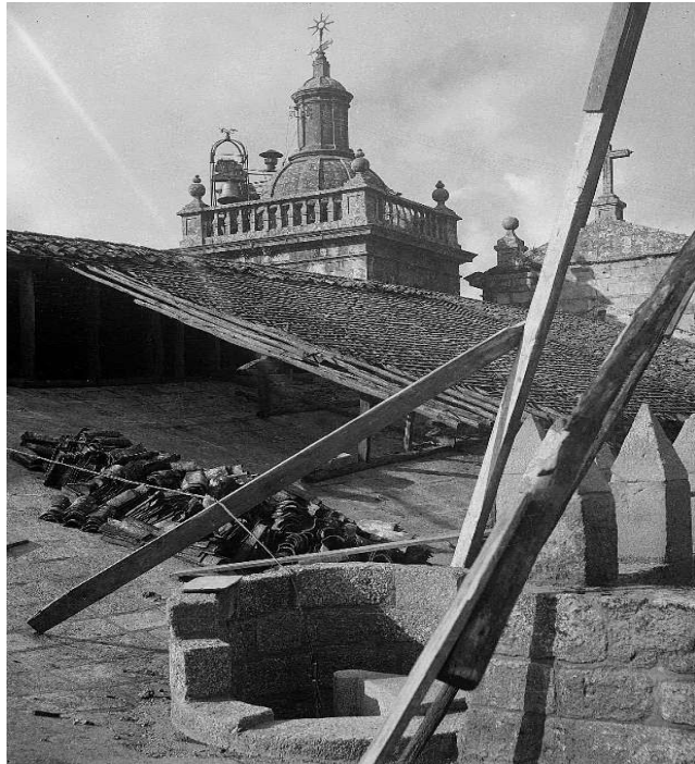
Fig. 13 – Remoção do telhado e respectiva colocação de ameias ao longo do corpo da catedral. DGEMN
