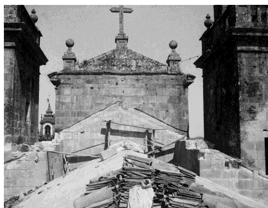
Fig. 4 – Cobertura da Sé após a remoção do telhado. DGEMN
