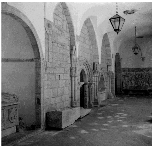
Fig. 28 – Restauro do claustro gótico da Sé. DGEMN
