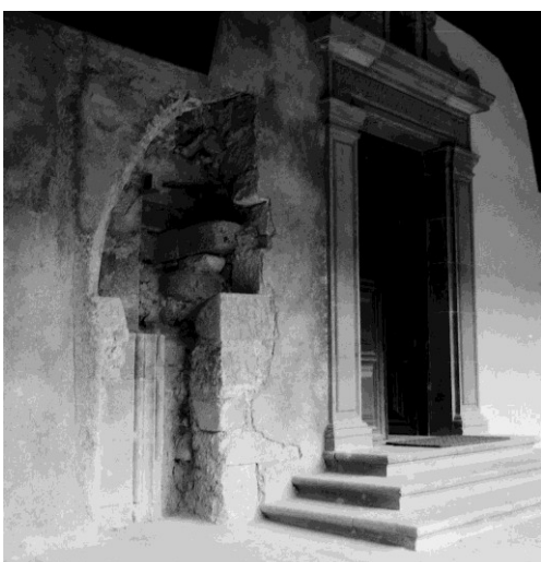
Fig. 25 – Descoberta do arco do claustro gótico no piso superior do claustro. DGEMN
