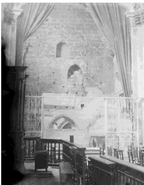
Fig. 9 – Braço sul do transepto após o desmantelamento da Capela do Santíssimo Sacramento. DGEMN
