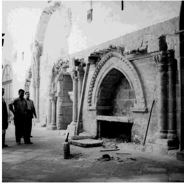
Fig. 26 – Momento de abertura do túmulo. DGEMN
