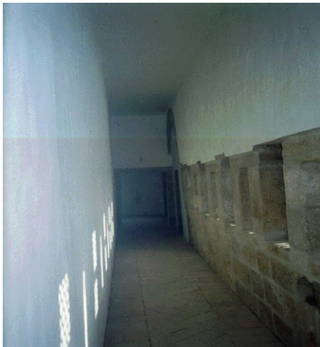
Fig. 7 – O mesmo espaço após o restauro. DGEMN
