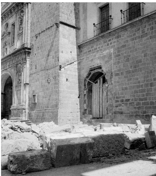
Fig. 16 – Demolição da capela de Santo António para proceder à construção de uma porta de acesso ao claustro. DGEMN
