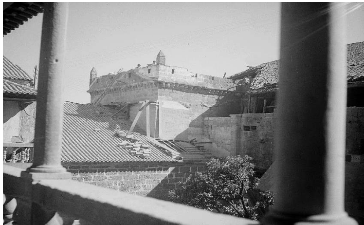
Fig. 11 – Momento de remoção do telhado para procederem à colocação das ameias. DGEMN
