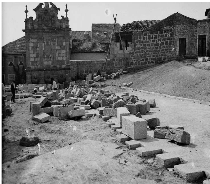
Fig. 37 – O mesmo local após a demolição do prédio e recolocação do cruzeiro. DGEMN
