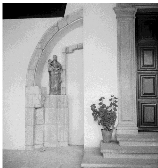
Fig. 26 – Aspecto do arco após o restauro. DGEMN
