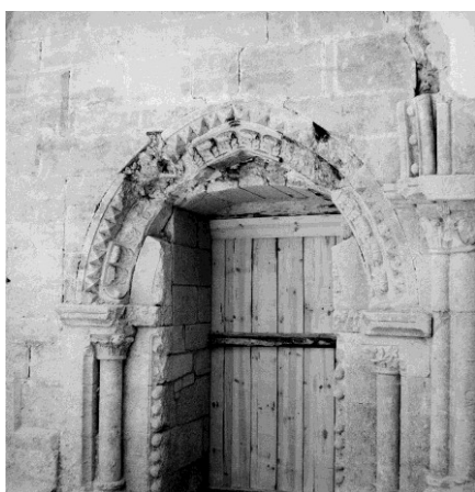
Fig. 13 – Portal da capela fúnebre durante o restauro. DGEMN
