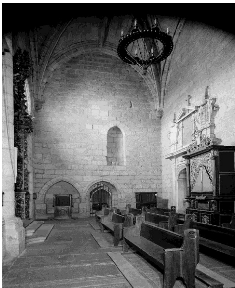
Fig. 11 – Braço sul do transepto depois do restauro. DGEMN
