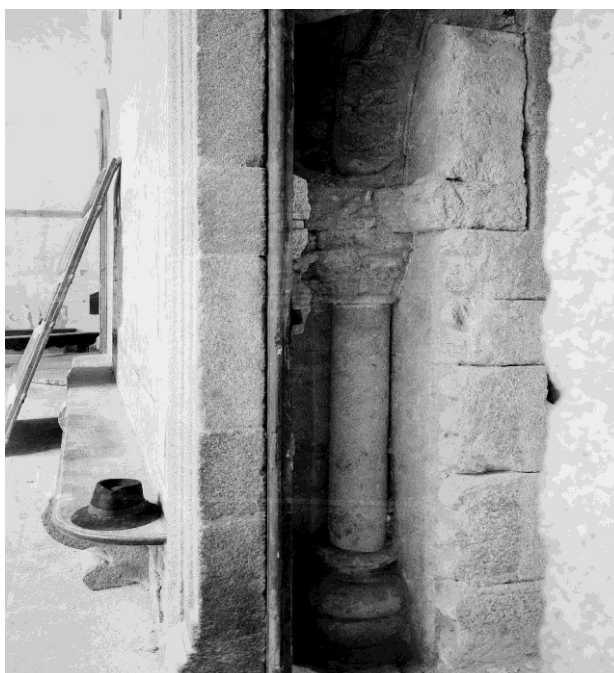
Fig. 24 – Pormenor do colunelo antes do restauro. DGEMN
