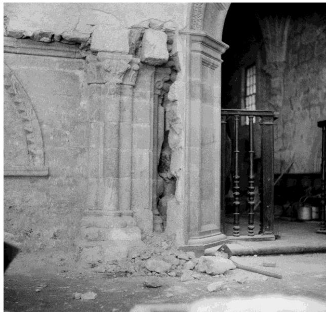
Fig. 27 – Extremo sudeste do claustro junto da capela Tércia. DGEMN
