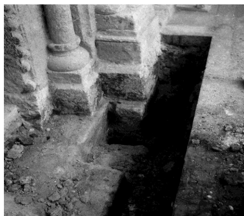
Fig. 14 – Escavações efectuadas junto do portal. DGEMN
