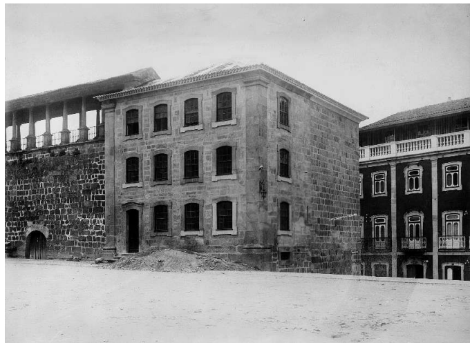
Fig. 38 – Trabalhos de adaptação da torre a residência paroquial. DGEMN
