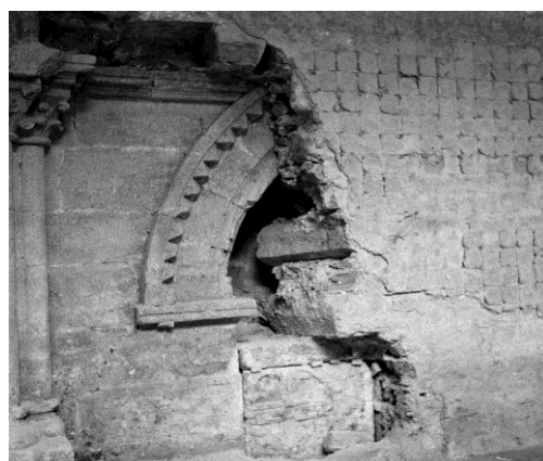
Fig. 16 – Descoberta do arcossólio e túmulo. DGEMN
