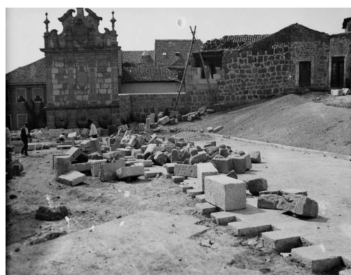
Fig. 28 – Colocação da pavimentação no largo fronteiro à igreja da Misericórdia. DGEMN
