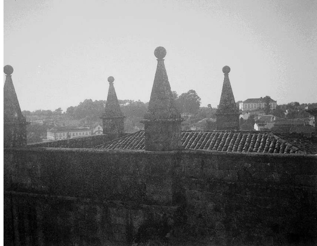
Fig. 2 – Telhado da capela-mor antes do restauro. DGEMN
