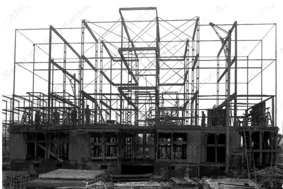
Fig.32 Esqueleto metálico da 'Cité du Champ-des-Oiseaux' em Bagneux.
