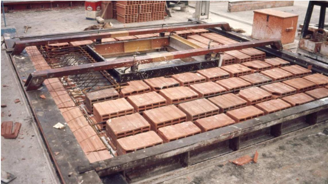
Fig.103 Pré-fabricação de parede resistente exterior com vão, reforçada, para uso nos cinco primeiros pisos dos edifícios em altura.
