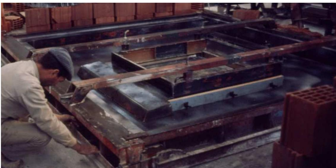
Fig.100 Primeiro aro do vão – painel resistente exterior.
