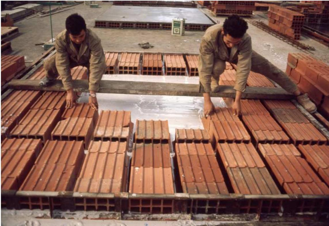
Fig.110 Pré-fabricação de uma laje.
