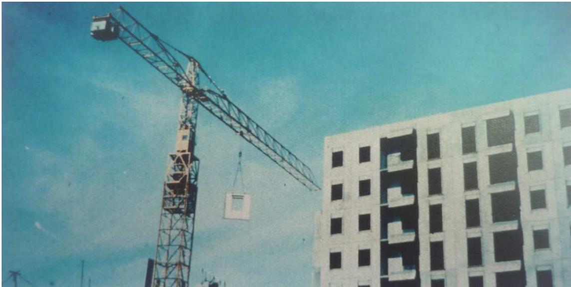
Fig. 41 Montagem de painéis no local. Santo António dos Cavaleiros, construção da empresa ICESA.
