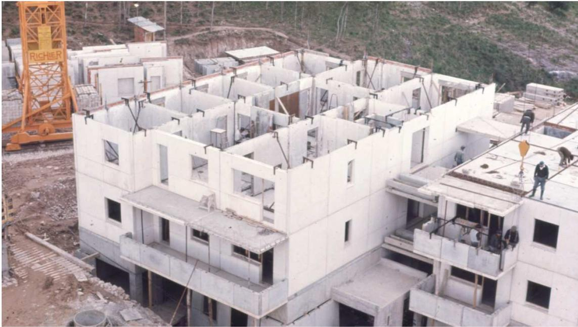
Fig.116 Montagem de uma torre da categoria I2C.
