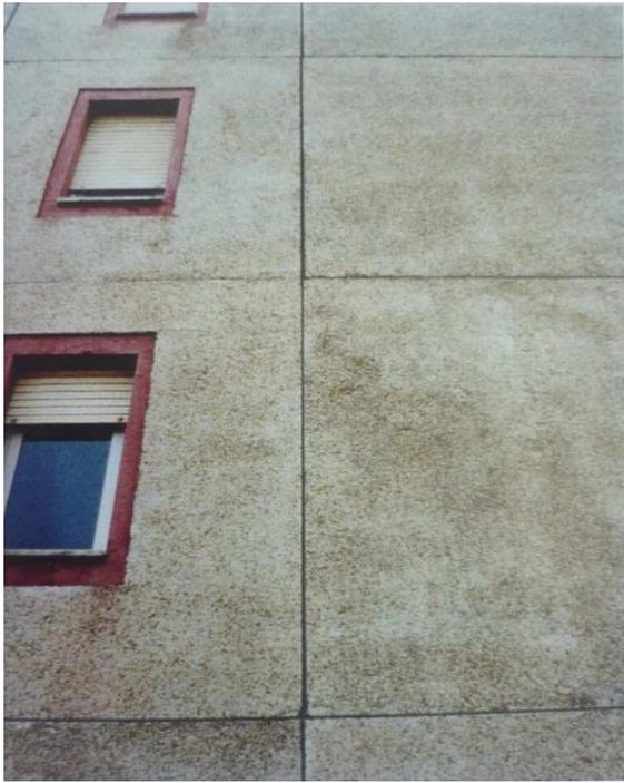
Fig.40 Incorrecta montagem de painéis exteriores.
