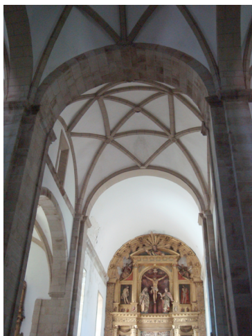
16. Cobertura dos tramos da capela-mor
