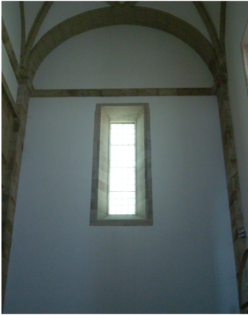
19. Janela alta do transepto, lado da epístola. As restantes janelas da igreja são semelhantes, mas de menores dimensões. Quando comparadas com as aberturas da Sé de Leiria, as janelas do caso mirandês são bastante mais pequenas.
