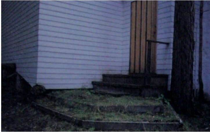
5.16 – Acesso à porta para cozinha e quarto independente - Casa Experimental, Alvar Aalto (Weston, 2005)
