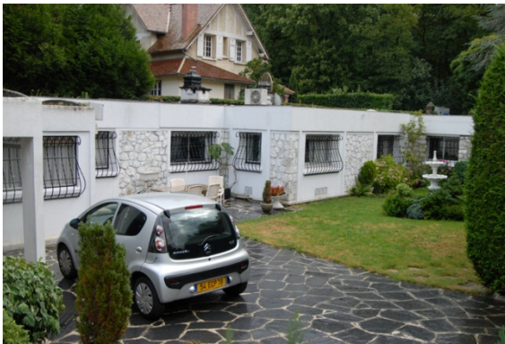
5.5 – Renovação da Casa de fim-de-semana, Le Corbusier (Google Earth Community: 60 Avenue du Chesnay, endereço aproximado)
